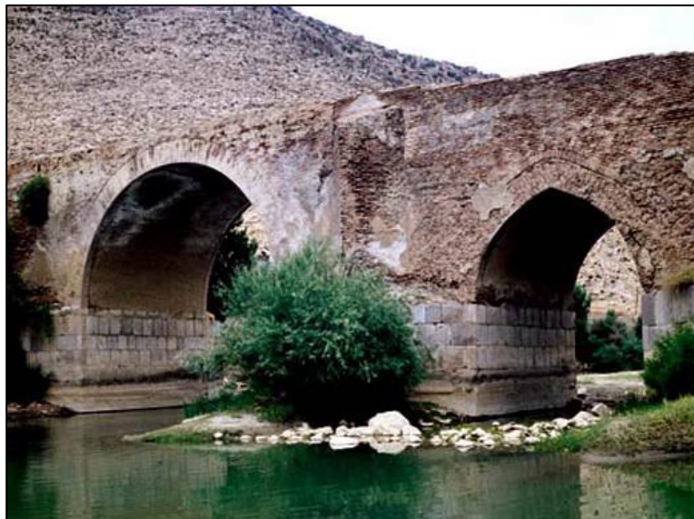
شکل ۴-۱۶- پل کوچه کرمانشاه
