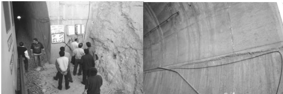
شکل ۲۱-۷ نصب تجهیزات در تونلها
