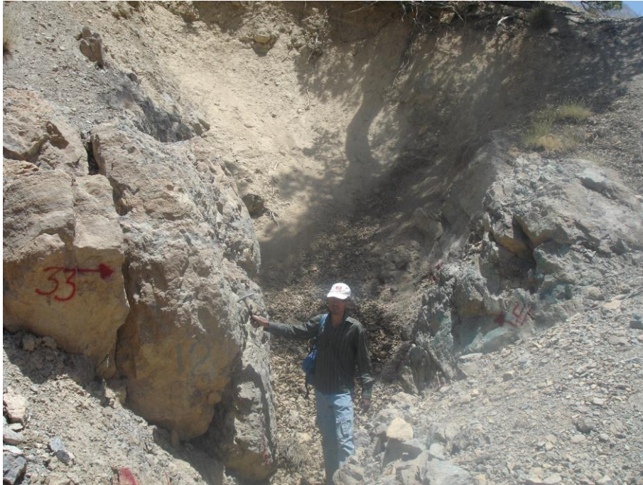
شکل 6-4: تصویر ترانشه حفر شده جهت اکتشاف ماده معدنی
