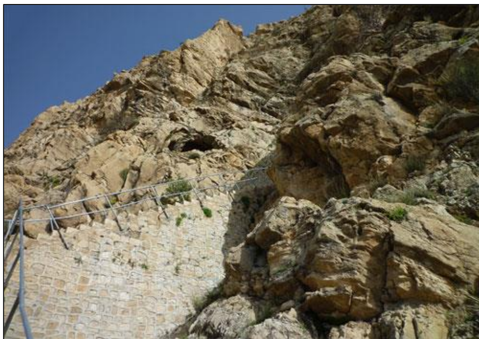
شکل ۴-۲۲- نمایی از پله‌های کنده‌شده در سنگ‌های کوه
