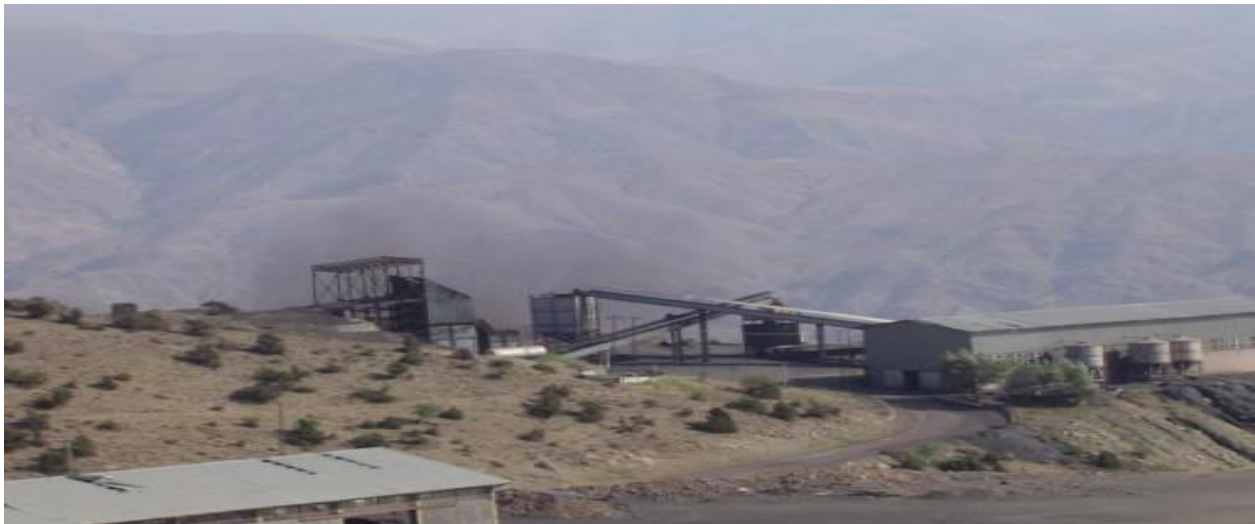
شکل ۲-۲۲- نمای کلی از کارخانه زغالشویی سنگرود
