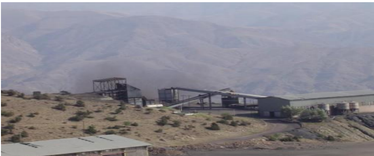
شکل ۲-۴ نمای کلی از کارخانه زغال‌شویی سنگرود
