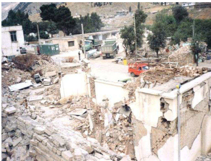
شکل ۴-۵ خرابی‌های ناشی از زلزله رودبار - منجیل
