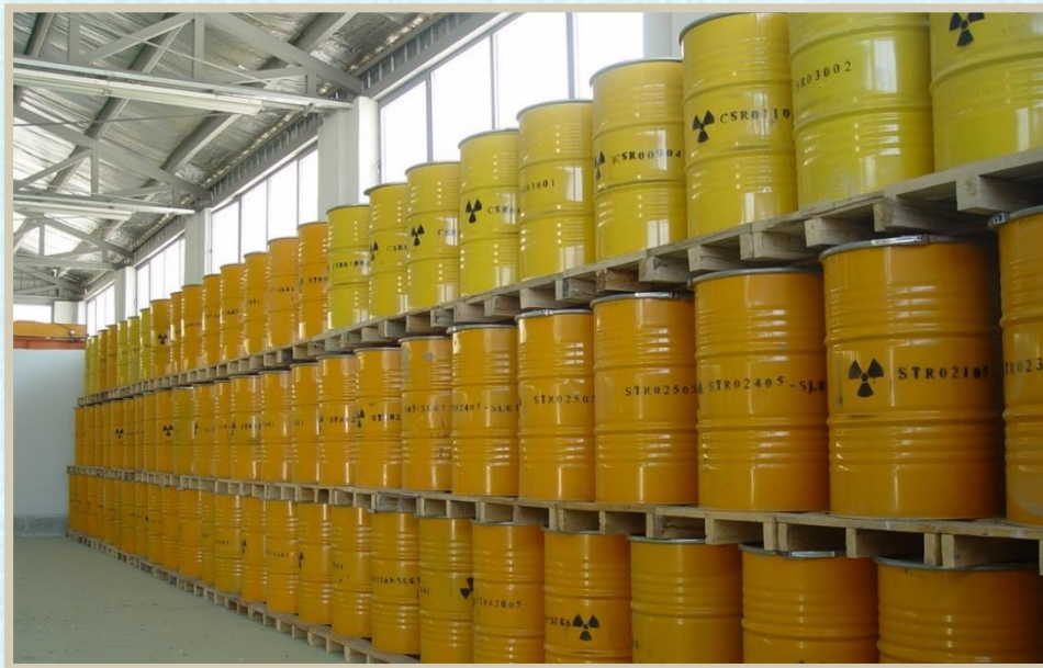
بشکه‌های نگهداری پسمان‌های پرتوزا
