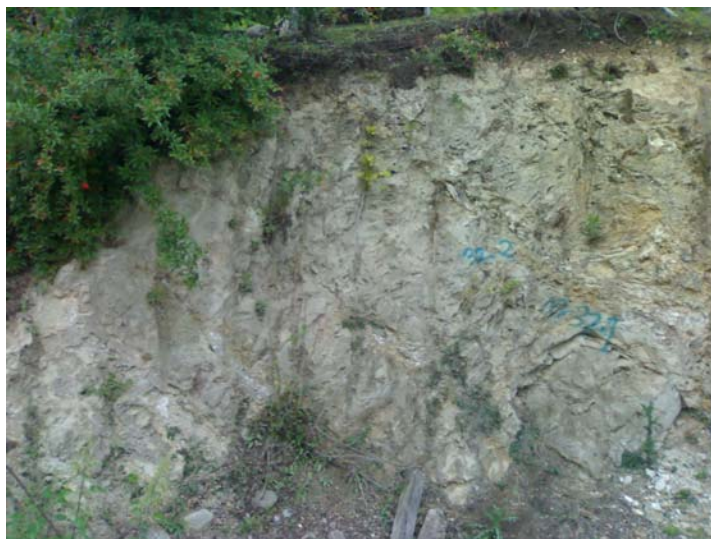
تصویر ۳-۱۹- آهک‌های مارنی هوازده در ابتدای مسیر ۳۲
