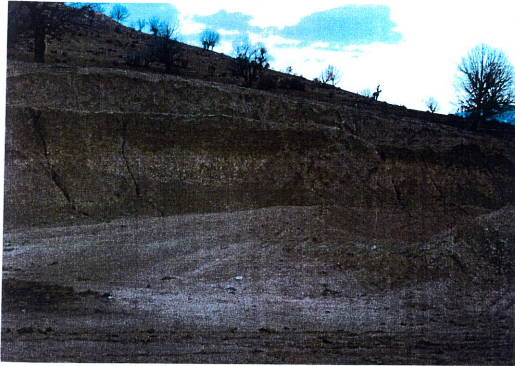
شکل ۳۲-۵ سینه کار معدن خاک کارخانه آجر دژ در مارن‌های سازند آغاچاری
