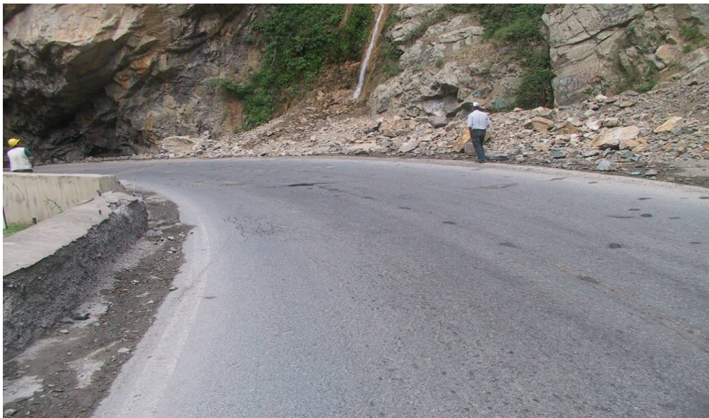
عکس ۳-۷- تصویری از یک بلوک رها شده بعد از زمین لرزه کجور در یکی از کنارگذرهای تونل در جاده چالوس، ابعاد بلوک رها شده قابل توجه است.
