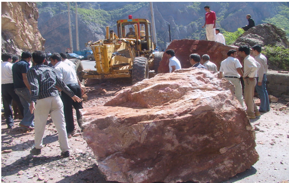
عکس ۳-۴- بلوک رها شده از شیب ۳۲، در مطالعه حاضر امتیاز این شیب بروش RHRS ۷۴۷ بوده است. اندازه گیری پارامترهای این شیب ساعتی پیش از وقوع این سنگ افت تکمیل گردیده بود!!!
