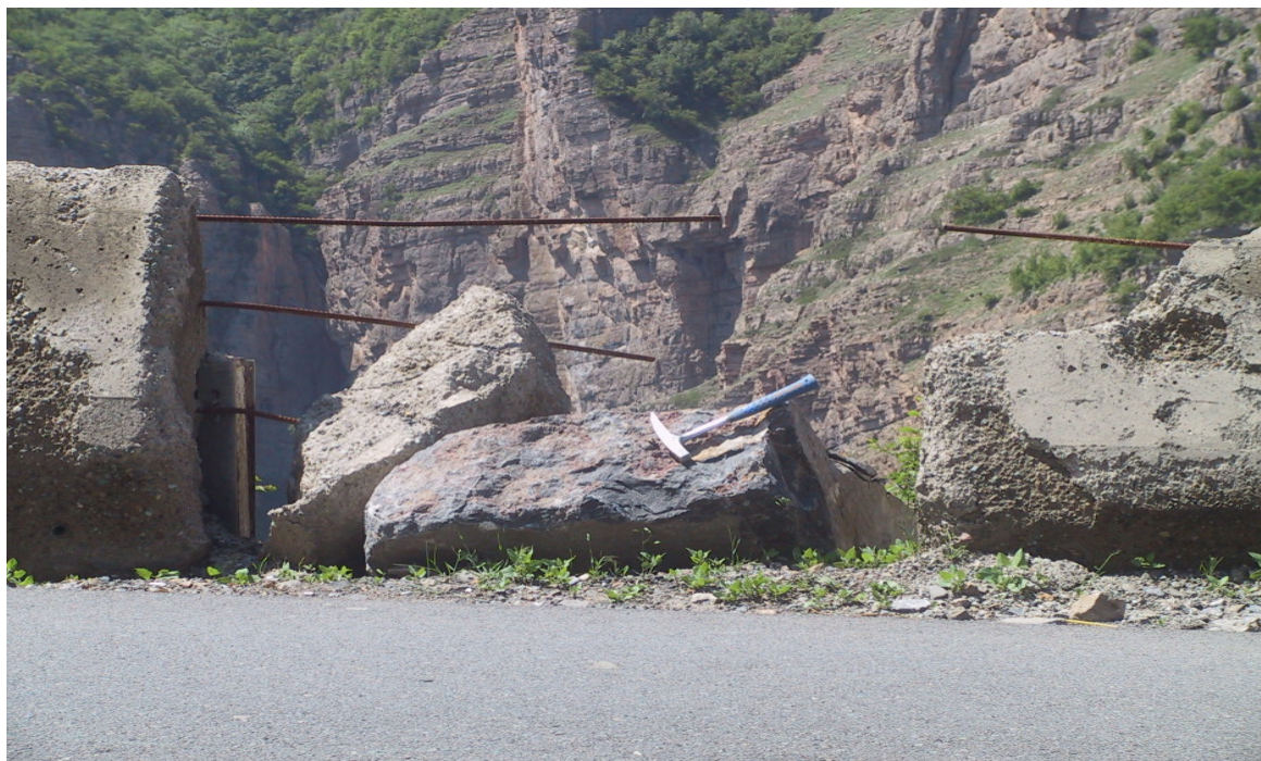
عکس ۳-۶- تصویری از گارد بلوک خرد شده در کنار جاده و مصالح تشکیل دهنده آن که در تصویر قابل مشاهده است.
