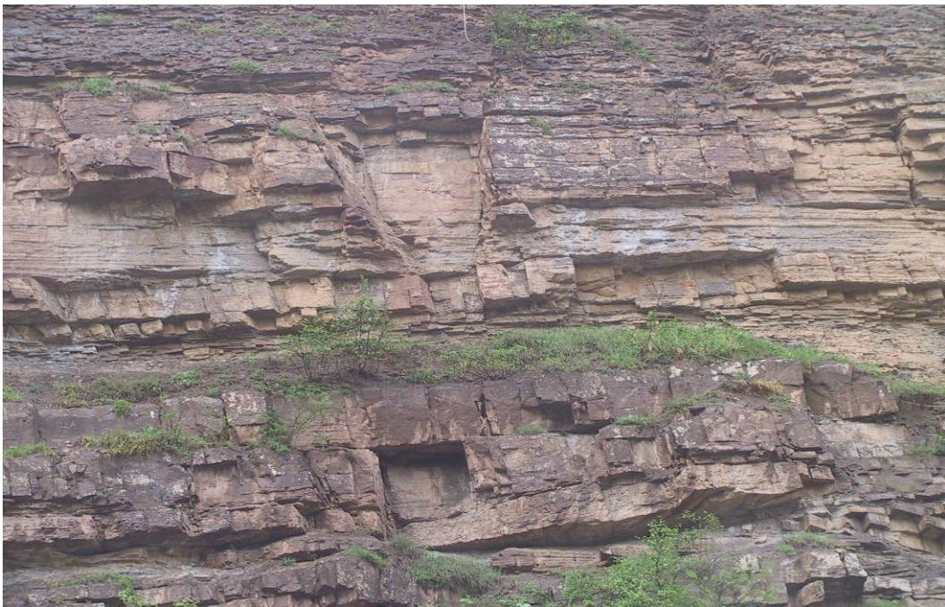
عکس ۱-۳ - نمونه‌ای از گسیختگی‌های صفحه‌ای در شیب‌های سنگی جاده چالوس
