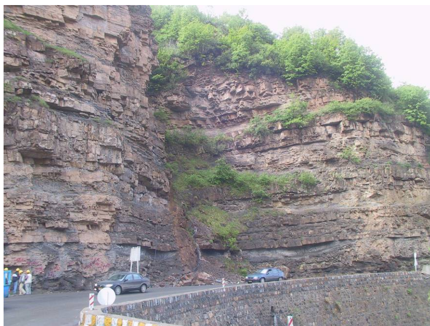
عکس شماره ۹-۴- نمای عمومی دامنه ماسه‌سنگی درود (S40) که با دارا بودن SMR برابر با ۵۴ و پتانسیل رخداد احتمالی ناپایداریهای گوه‌ای و صفحه‌ای به نگهدارنده‌های کاملی جهت افزایش پایداری نیاز دارد.
