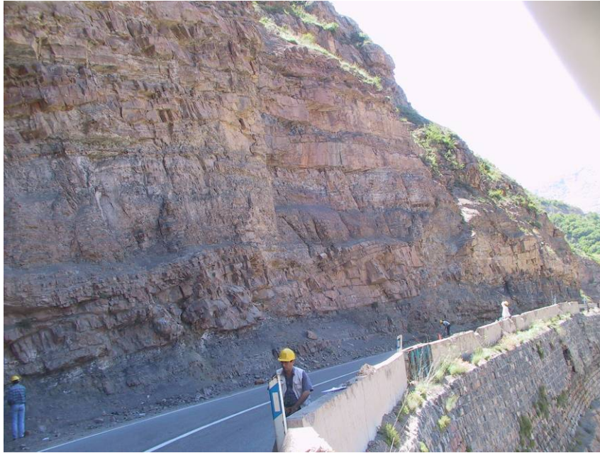
عکس شماره ۴-۱۱- نمای عمومی دامنه سنگ آهک مبارک (S37) که توالی لایه‌های سنگ آهک و شیل- مارن تیره‌رنگ و موقعیت فضایی شیب دامنه سنگی و ناپوستگی‌های دربرگیرنده آن موجب ناپایداری‌های صفحه‌ای در آن گردیده است.
