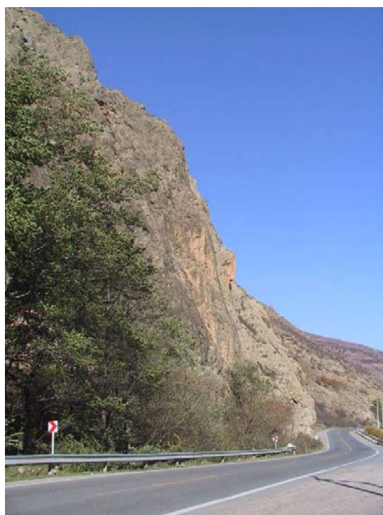
عکس شماره ۴-۱۸- نمای عمومی دامنه سنگ آهک دولومیتی (S3) که با احتمال رخداد ناپایداریهای صفحه‌ای/گوه‌ای و رهاسازی بلوکهای سنگی بزرگ همراه است.
