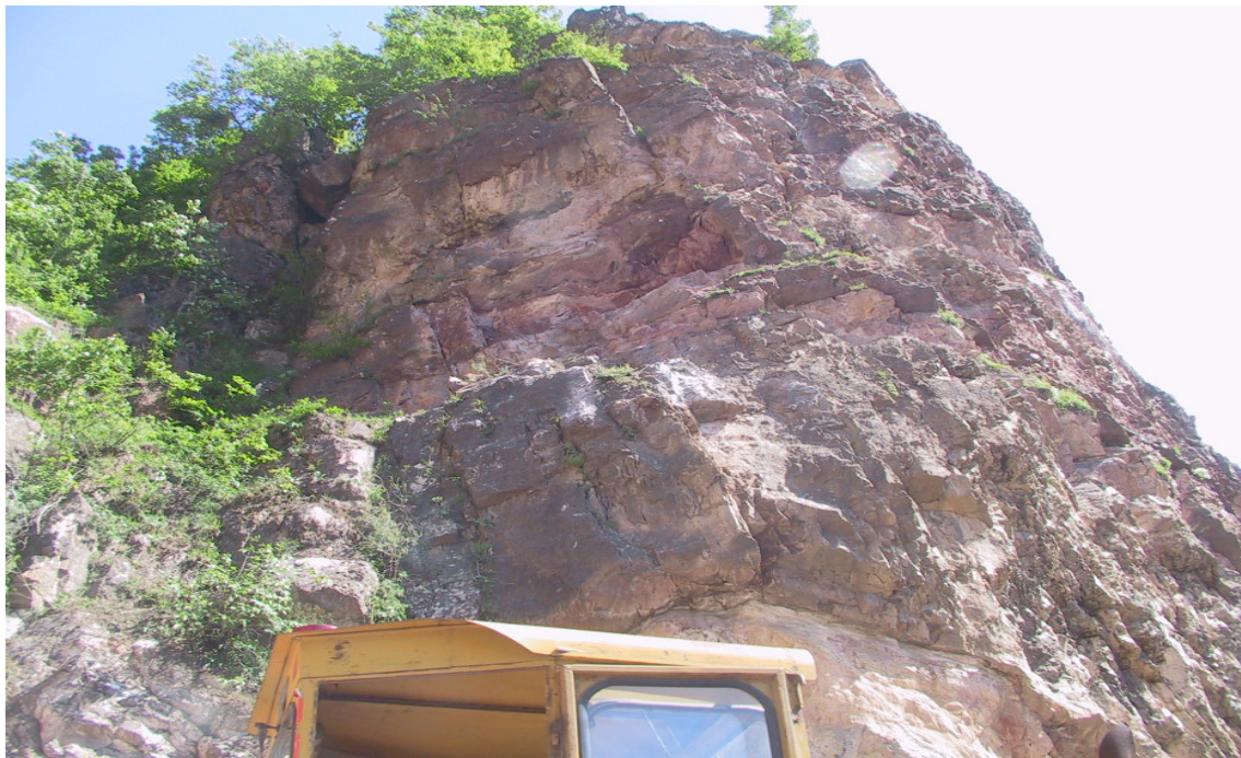
عکس ۳-۵- مخزن سنگ افت (Source of rockfall) بر روی شیب شماره ۳۲ ارتفاع این مخزن حدود ۳۰ متر بوده است.
