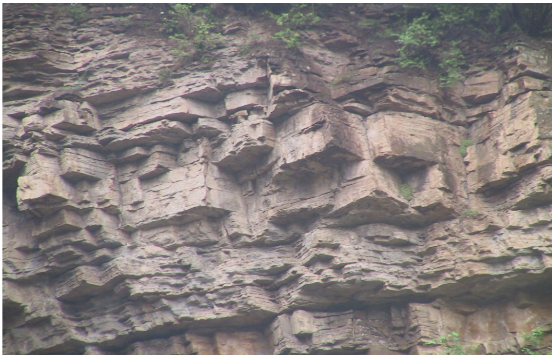
عکس ۲-۳ - نمونه‌ای از گسیختگی گوه‌ای در شیب‌های سنگی جاده چالوس
