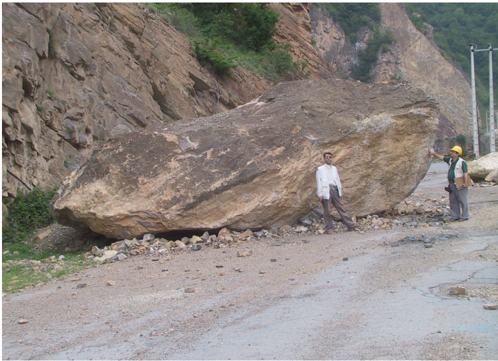
عکس ۳-۷- تصویری از یک بلوک رها شده بعد از زمین لرزه کجور در یکی از کنارگذرهای تونل در جاده چالوس، ابعاد بلوک رها شده قابل توجه است.
