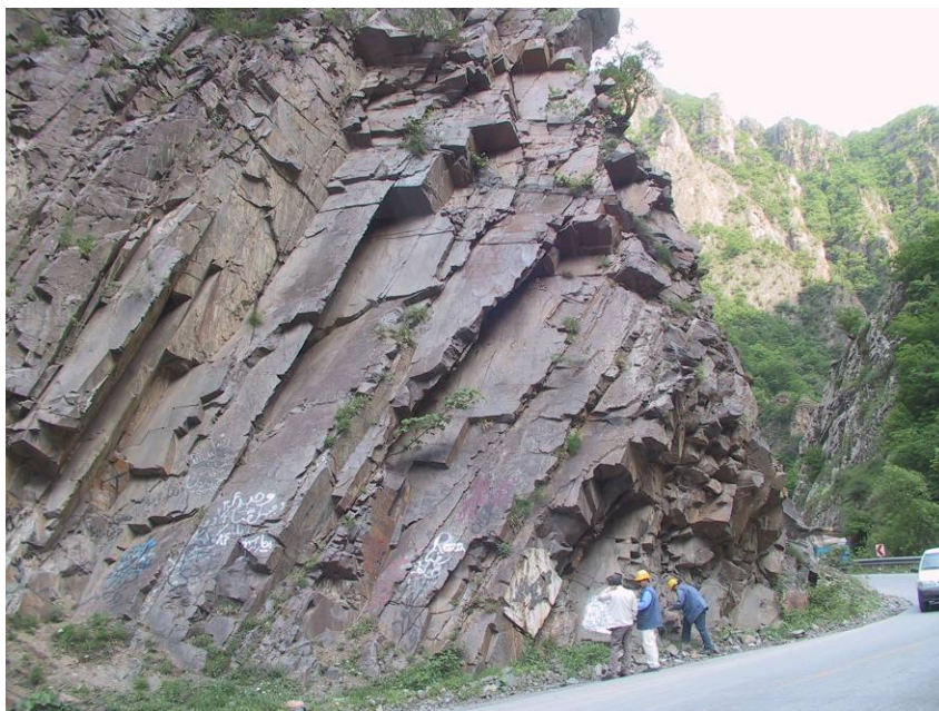
عکس شماره ۳-۱- نمای عمومی دامنه ماسه‌سنگی کهر (S17) که با دارا بودن SMR برابر با ۷۴ به حداقل میزان نگهدارنده نیازمند می‌باشد.
