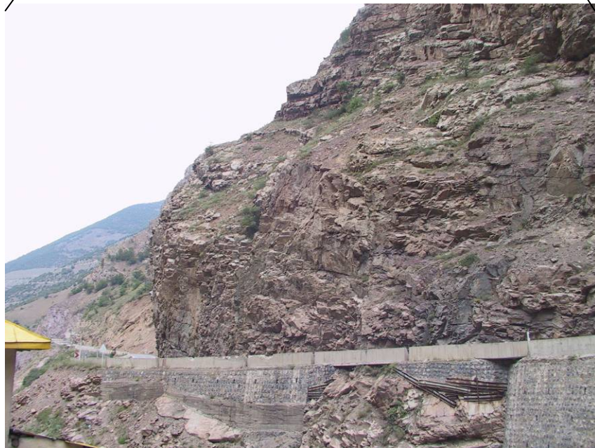
عکس شماره ۳-۸- نمای عمومی دامنه ماسه‌سنگی لالون (S26) در بالادست راهدارخانه هزار چم که احتمال رخداد ناپایداری واژگونی و میزان خردشدگی توده‌سنگها در آن بیشتر از دامنه (S27) می‌باشد.
