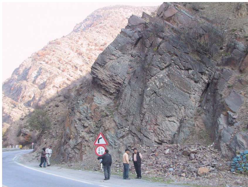
عکس شماره ۴-۲۱- نمای عمومی دامنه فورش سنگی (S5) که با در نظر گرفتن وضعیت لایه‌بندی و ارتفاع به نسبت کم آن، با آزاد شدن گوه‌های سنگی به نسبت کوچک می‌تواند همراه باشد.
