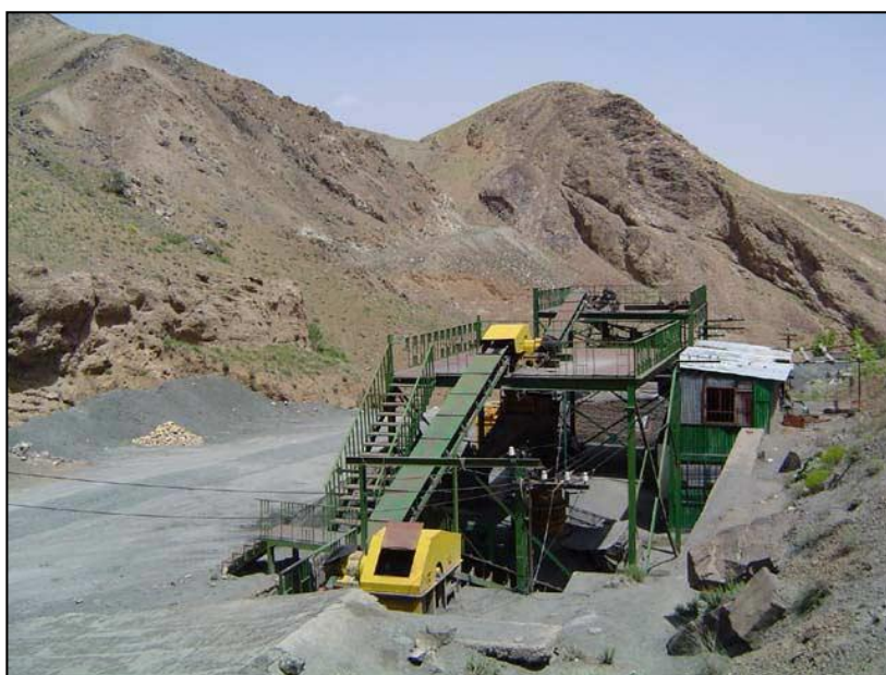
شکل ۲-۵۵- نمای کلی از کارخانه تغلیظ کرومیت گت
