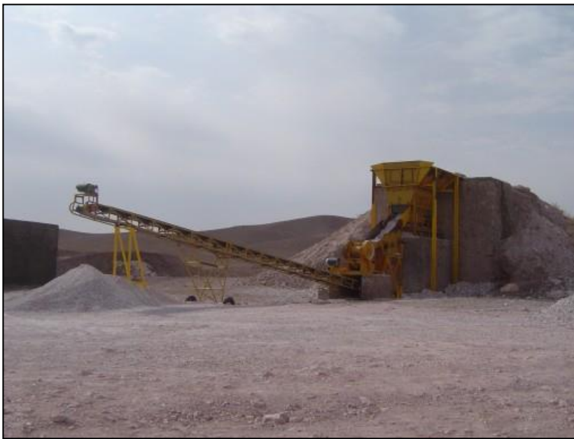
شکل ۲-۵۶- نمایی از تجهیزات مورد استفاده در کارخانه کائولن باغ آسیا
