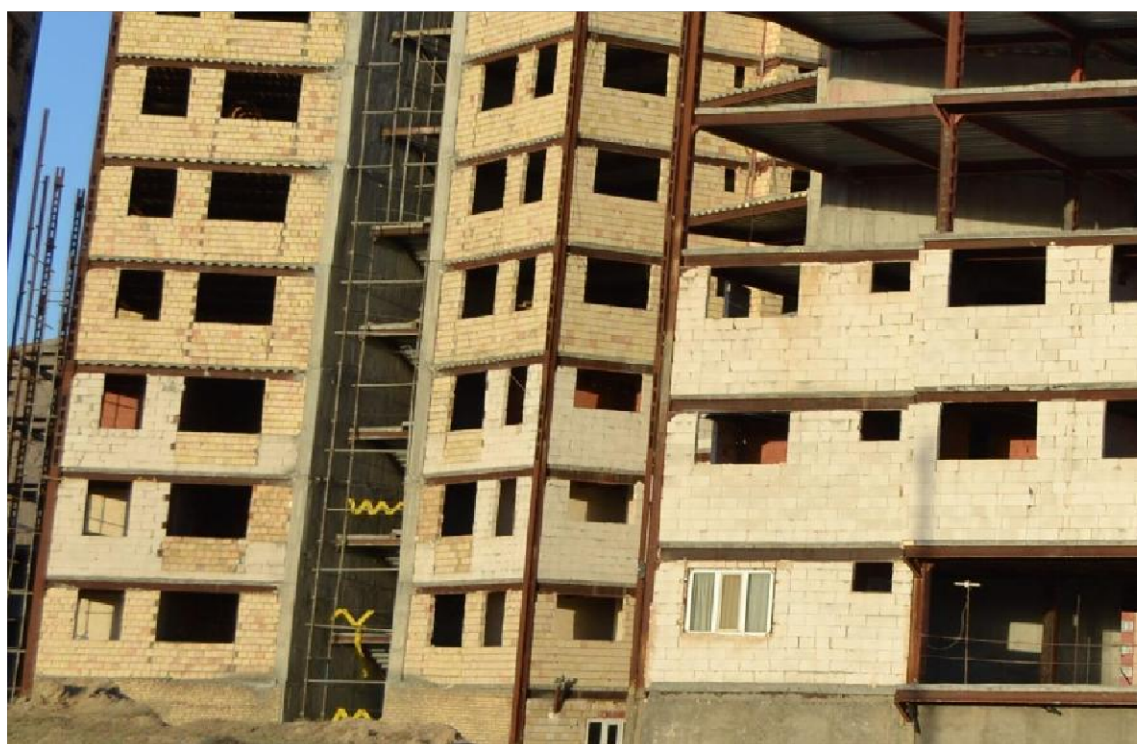
شکل ۲-۵ استفاده همزمان از هبلکس و بلوک سفالی
