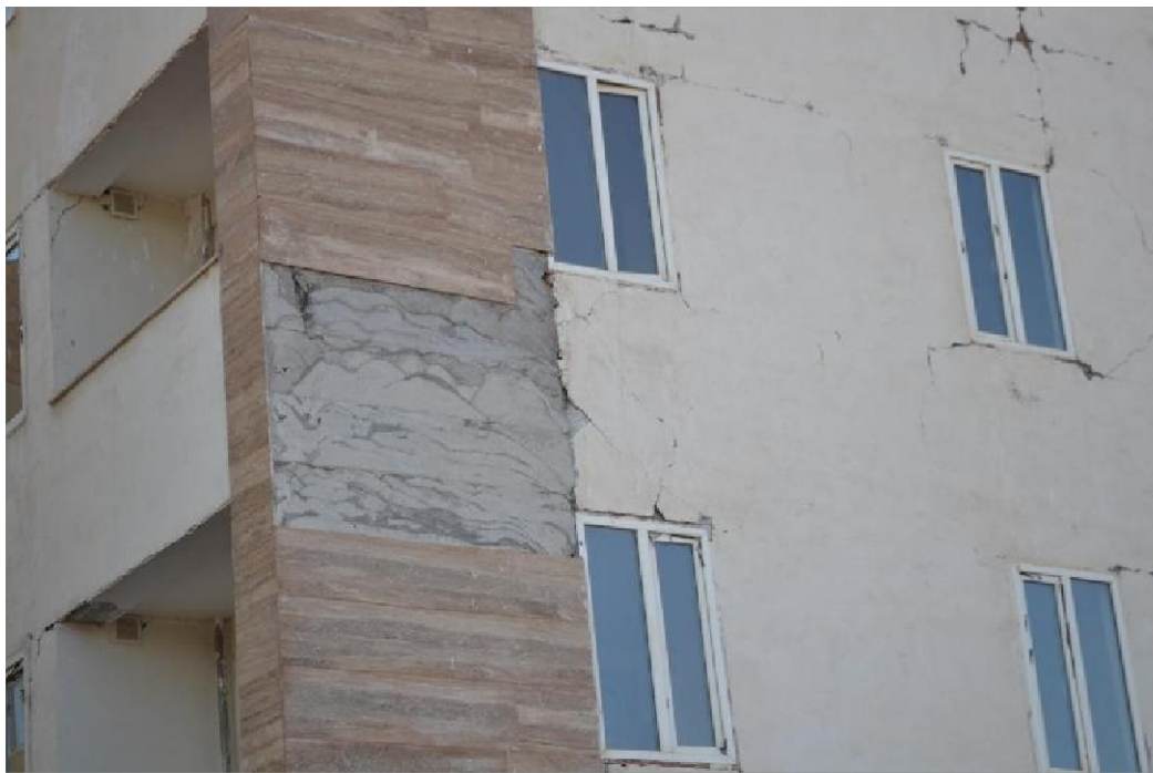
شکل ۲-۱۰ اسکوپ نکردن سنگ نما
