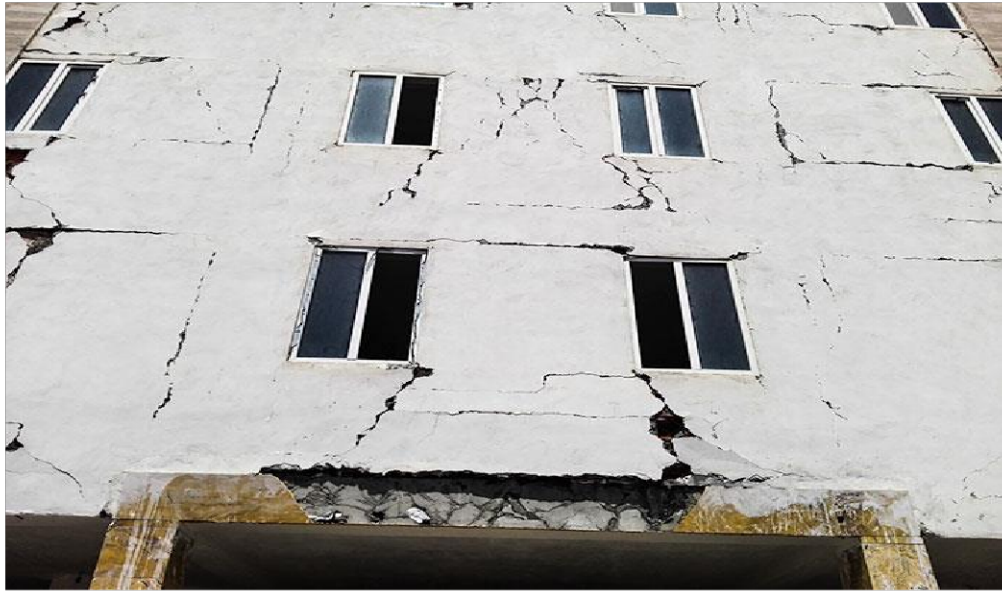
شکل ۲-۹ استفاده از نخاله ساختمانی در ملات
