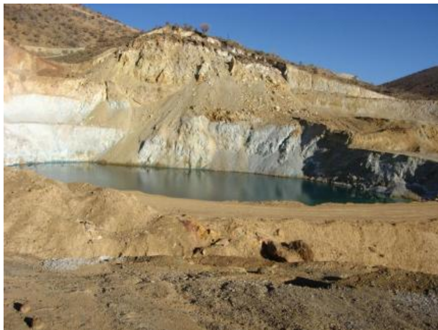
تصویر ۴-۱۸ پیت معدنی دره زار دارای کانه سازی کربناتی مس در ایستگاه IP-14
