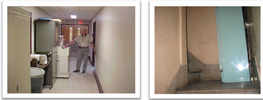
شکل پ-۱۵: نمونه‌هایی از ایجاد مانع در راه‌های خروج که منجر به کاهش پهنای مفید آن شده است
