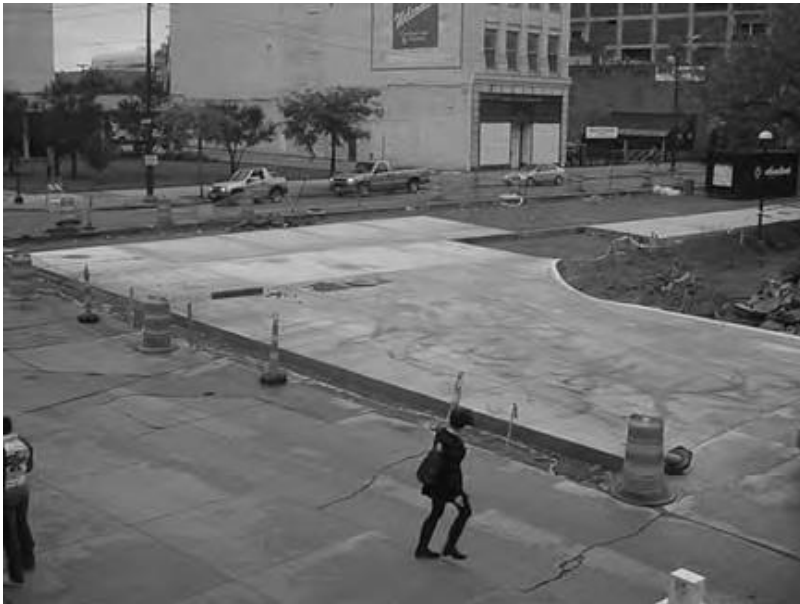
شکل ۹-۹: اجرای چهار مرحله‌ای تقاطع شهری در مرکز شهر کلیولند (عکس از نویسنده)
