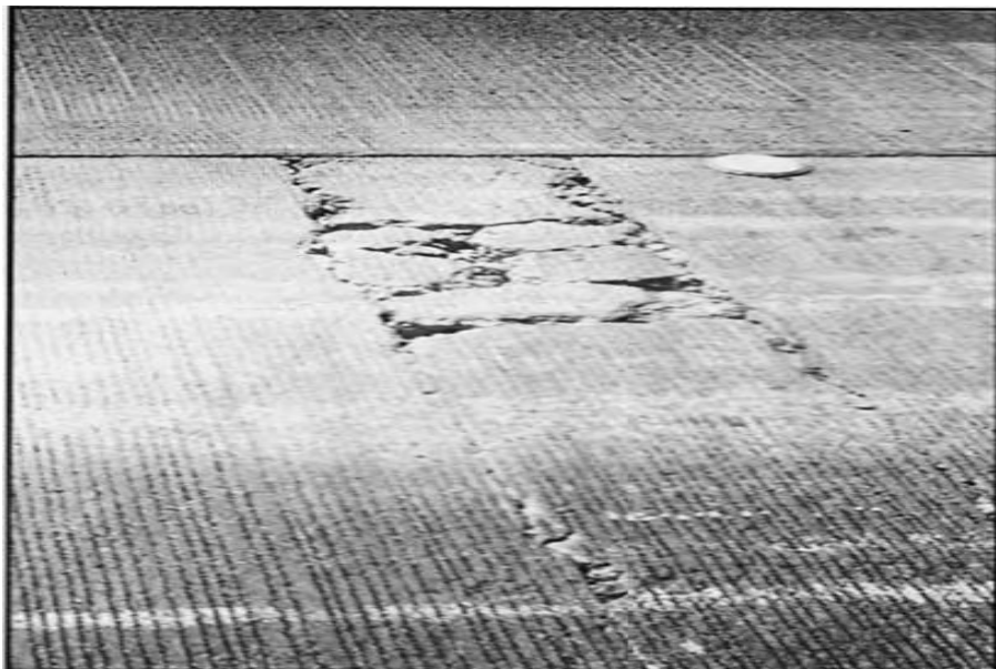
شکل ۳-۱۲: سوراخ‌شدگی با شدت زیاد (Miller & Bellinger, 2003: 79)
