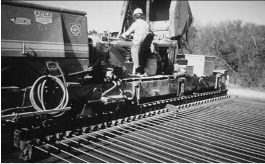
شکل ۱۴-۸: نصب آرماتور CRCP به وسیله تغذیه کننده لوله‌ای (ACPA 1996a:VI-37)
