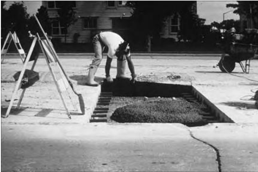
شکل ۱۷-۳: تعمیر عمقی با میلگردهای اتصال و صفحه الیافی به منظور جداسازی (ACPA:1996a)
