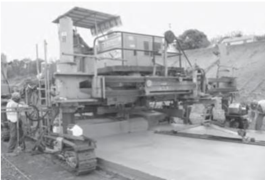
شکل ۱-۲: دستگاه روساز لغزنده (منبع عکس از شرکت ساختمانی Great Lake، هنکلی، اوهایو)
