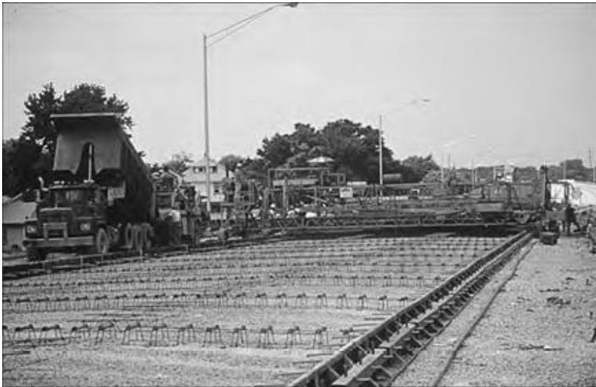
شکل ۱۴-۹: اجرای روسازی با قالب‌های ثابت (ACPA 1996a:VI-68)
