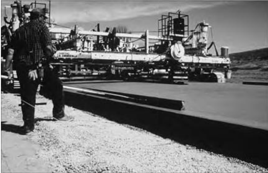
شکل ۱۴-۲: روسازی بتنی تولید شده با استفاده از قالب لغزنده (ACPA 1996a: VI-6)
