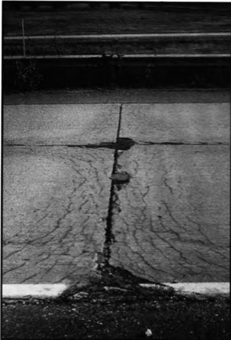
شکل ۳-۲: ترک خوردگی نوع D با شدت زیاد (Miller & Bellinger, 2003: 37)
