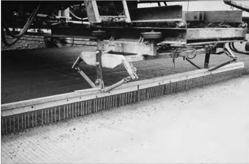
شکل ۱۵-۱: دندان‌های عرضی برای ایجاد بافت سطحی درشت (ACPA 1996a: VI-53)
