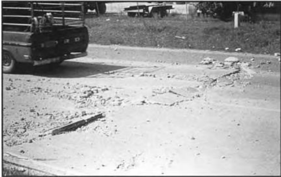
شکل ۳-۹: ترکیدگی (Miller & Bellinger, 2003: 52)
