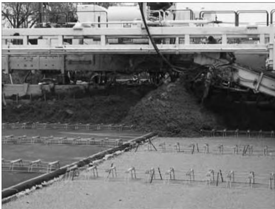
شکل ۱۸-۳: اجرای روکش بدون پیوستگی در دو خط عبور و اجرای همزمان روسازی در خط عبور سوم (Dale Crowl)
