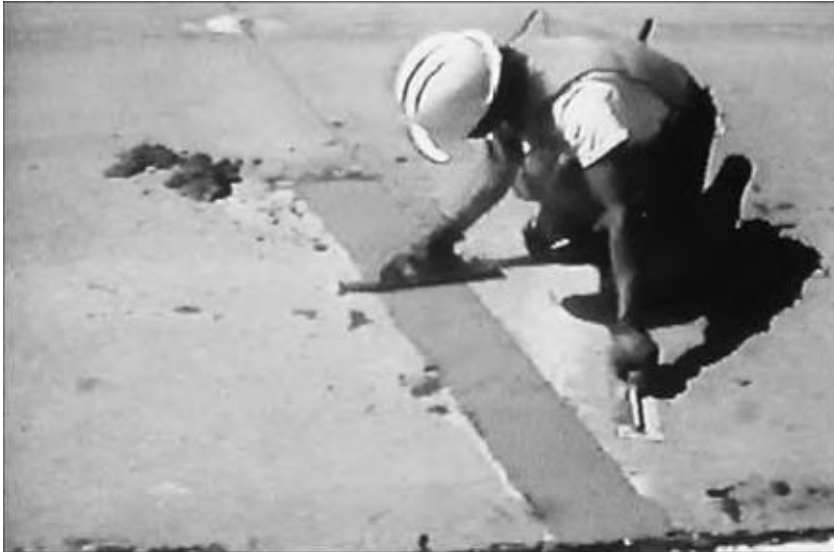
شکل ۱۷-۲: تعمیر نیمه عمیق (ACPA 1996a: VIII-57)
