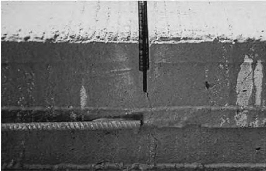
شکل ۱۵-۳: برش اولیه و برش تعریض کننده در درز عرضی (ACPA 1996a: VII-11)
