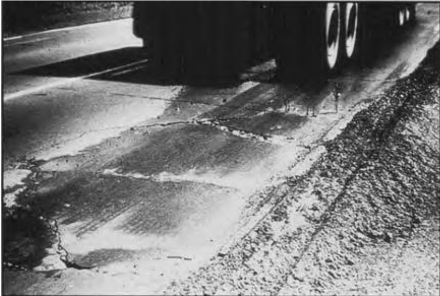
شکل ۳-۱۱: مکش و رو زدگی آب (Miller & Bellinger, 2003: 58)
