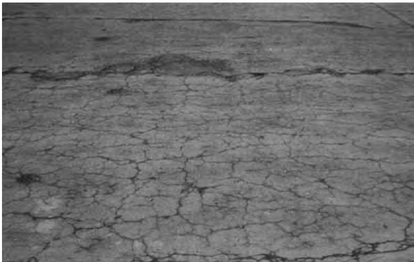
شکل ۳-۶: ترک‌خوردگی سطحی (Miller & Bellinger, 2003: 48)
