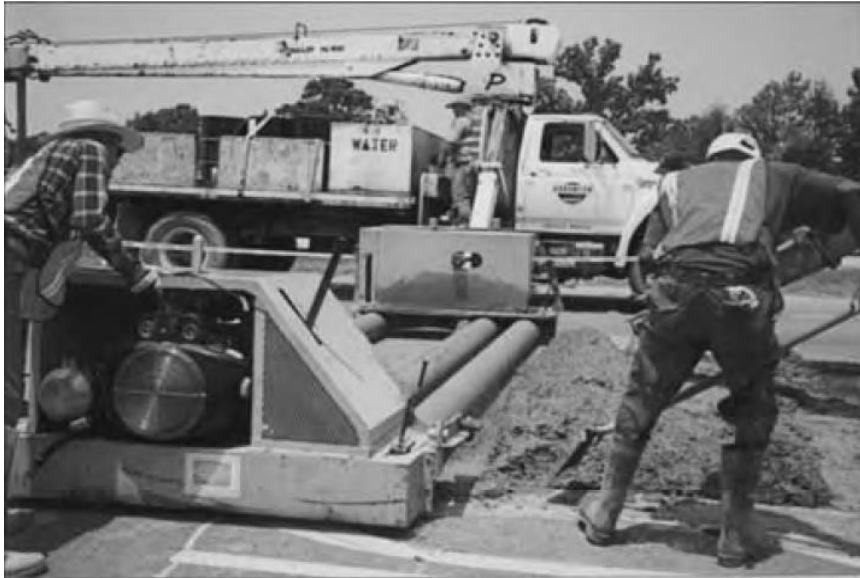
شکل ۱۸-۸: اجرای روکش‌های بتنی فوق نازک به عنوان رویه میانی (عکس از نویسنده)
