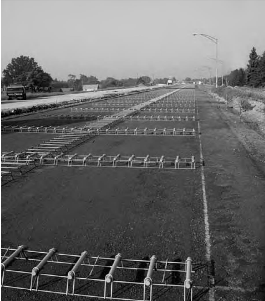
شکل ۱-۱: شبکه‌های آرماتور اتصال و خاموت در راستای فضا سازی مناسب برای دستگاه روساز لغزنده (منبع عکس از شرکت ساختمانی Great Lake، هنکلی، اوهایو)
