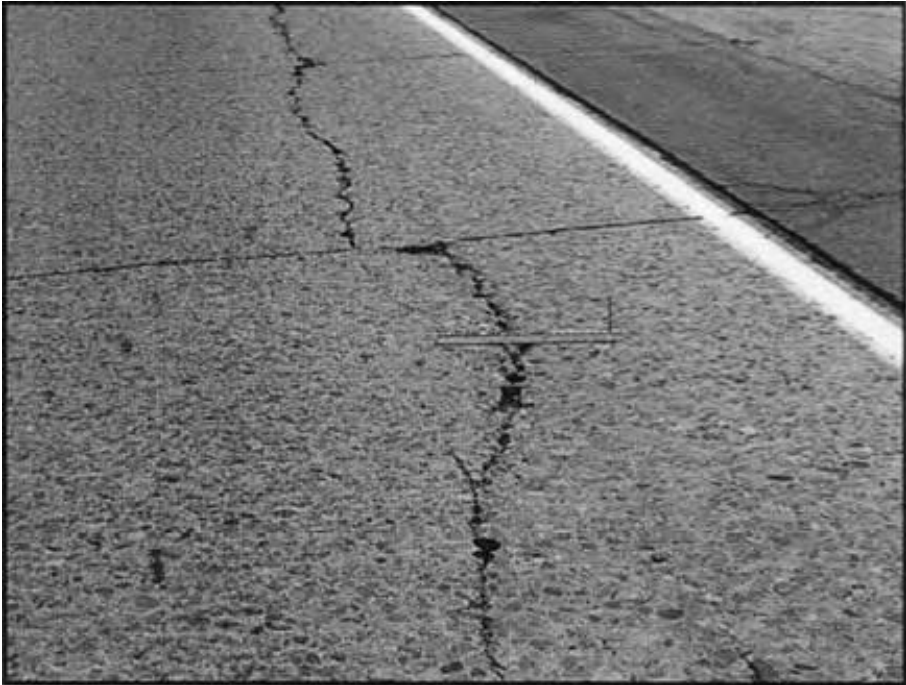
شکل ۳-۳: ترک طولی با شدت زیاد (Miller & Bellinger, 2003:39)
