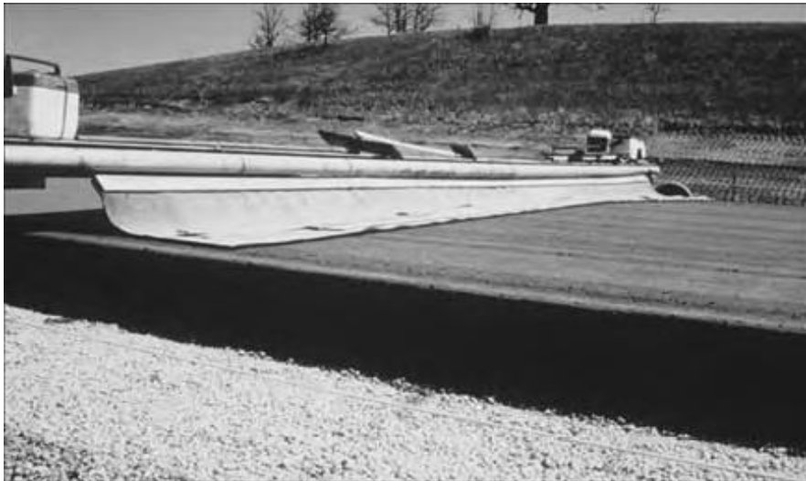
شکل ۱۵-۲: کشیدن گونی کرباسی برای ایجاد بافت سطحی ریز (ACPA 1996a: VI-53)
