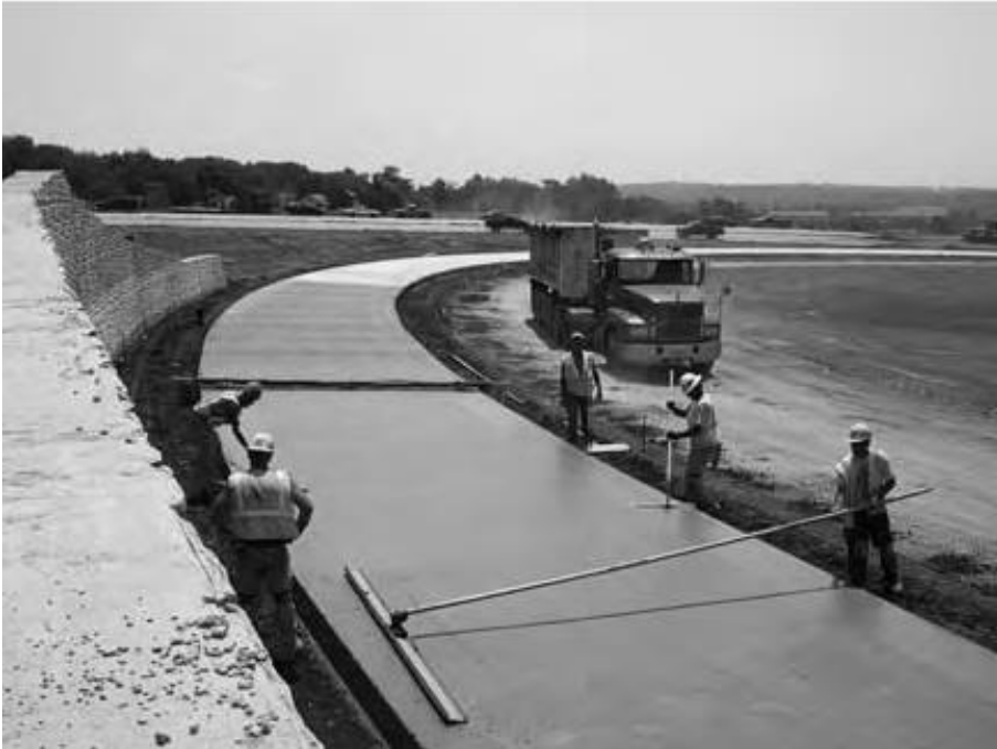
شکل ۱-۳: پرداخت روسازی در قوس (منبع عکس از شرکت ساختمانی Great Lake، هنکلی، اوهاйо)
