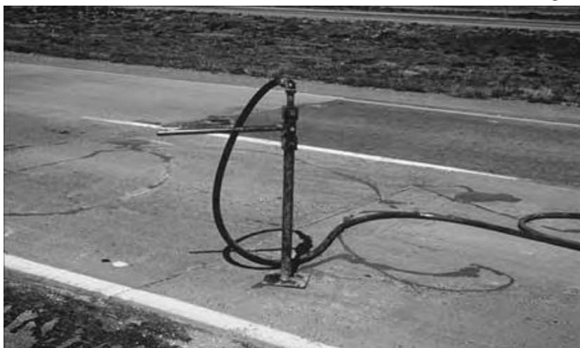
شکل ۱۷-۶: تزریق دوغاب به منظور پایدارسازی دال (ACPA 1996a: VIII-23)
