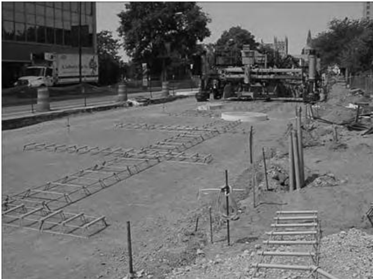
شکل ۲-۶: شبکه آرماتورگذاری با پوشش اپوکسی ضد خوردگی
