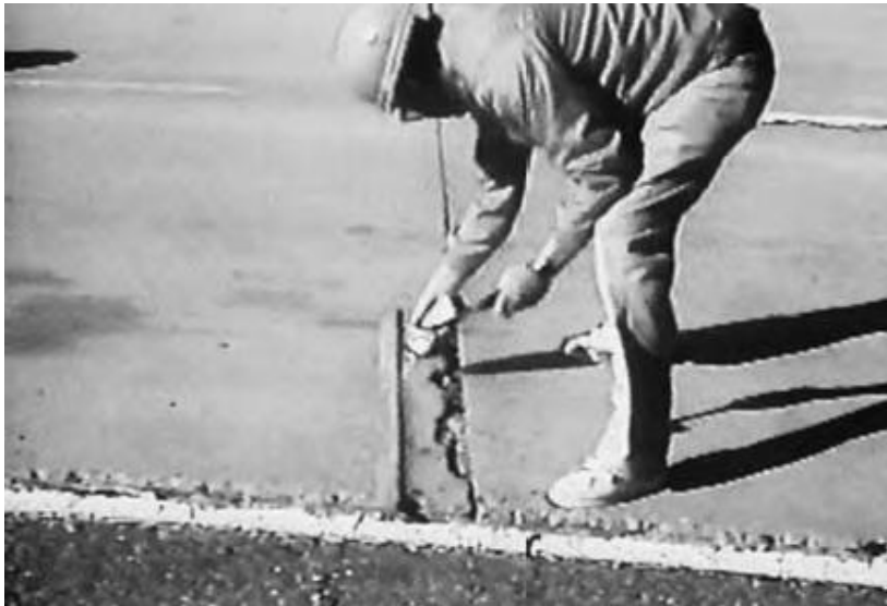
شکل ۳-۵: پوسته‌شدگی درزهای عرضی با شدت زیاد (ACPA 1996a: VIII-47)
