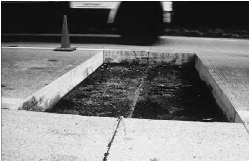
شکل ۱۷-۱: گودال آماده‌شده به منظور وصله عمیق در محل درز (ACPA 1996a: VIII-28)
