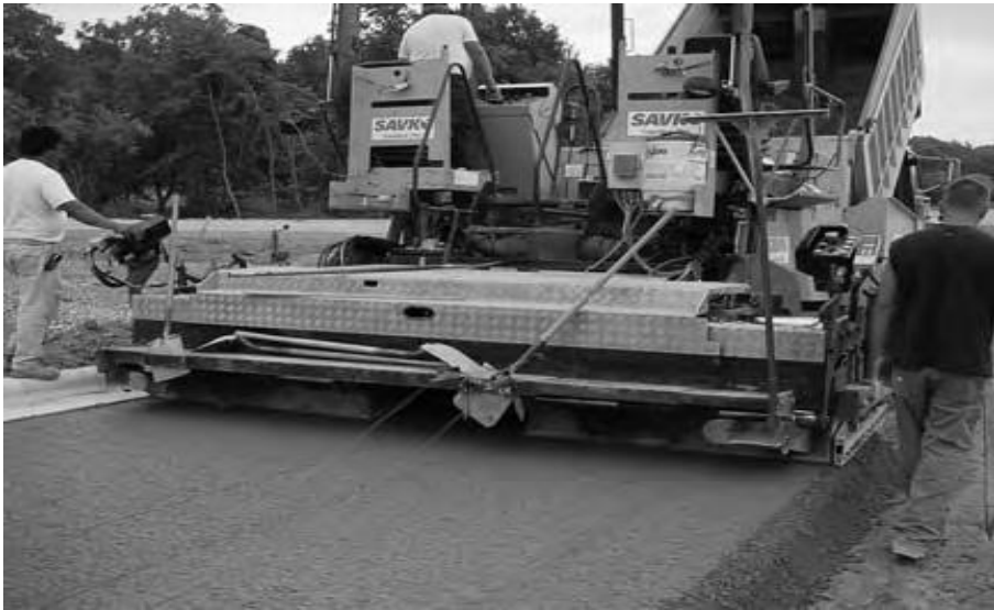
شکل ۲-۱۰: اجرای روسازی بتن غلطکی متراکم- کلومبوس، اوپاهو
