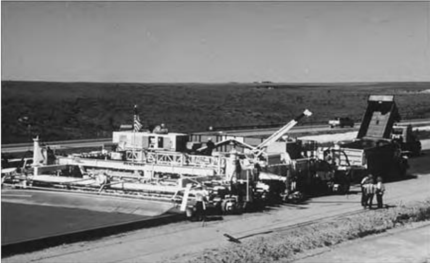
شکل ۱۴-۱: ماشین اجرای روسازی با قالب لغزنده (ACPA 1996a: VI-6)
