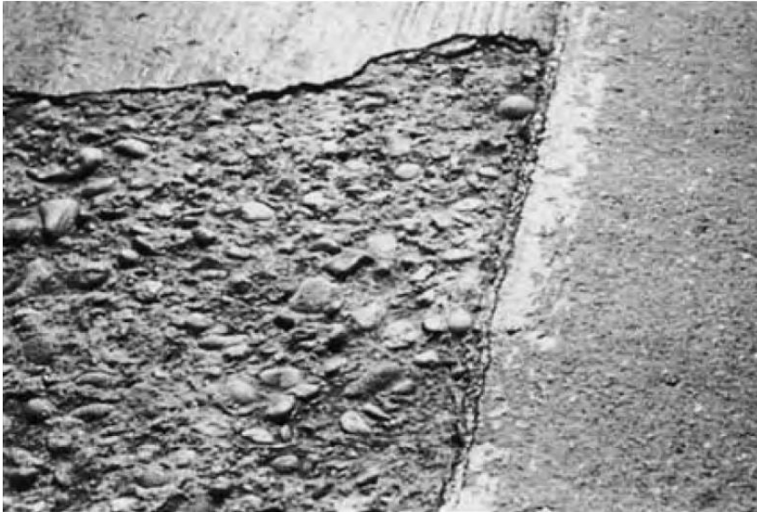
شکل ۳-۷: پوسته‌شدگی (Miller & Bellinger, 2003: 48)
