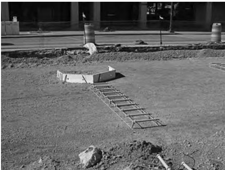
شکل ۲-۴: میلگردهای اتصال با پوشش اپوکسی مقاوم در مقابل خوردگی
