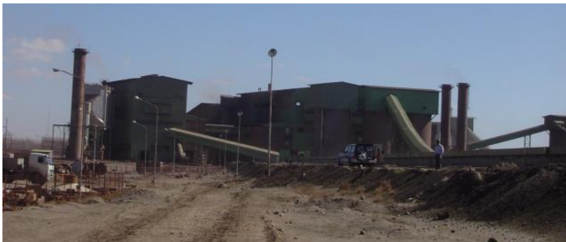
شکل ۲-۴ نمای کلی از کارخانه سنگ آهن گل گهر
