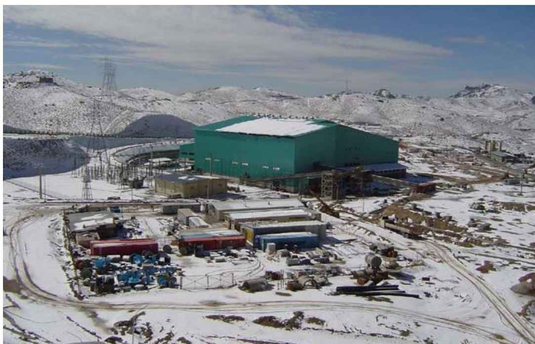
شکل ۴-۵ نمای کلی از کارخانه تغلیظ مس میدوک
