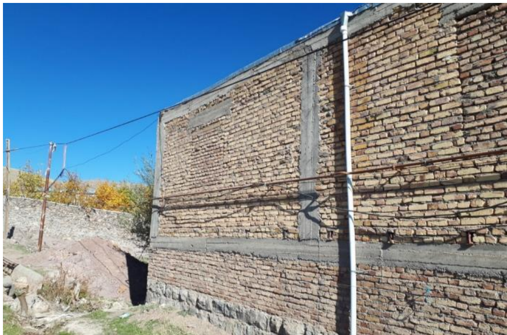
شکل ۲-۳۹ عملکرد مناسب لرزه‌ای سازه بنایی کلاف‌دار در منطقه ورنکش
