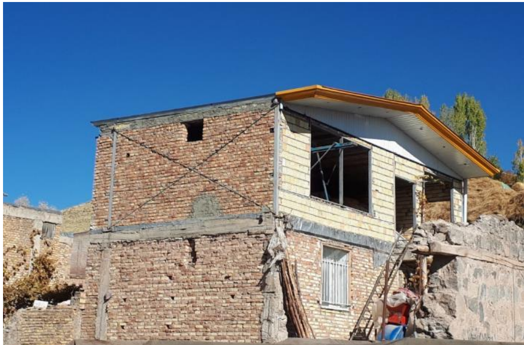
شکل ۴۱-۲ عملکرد مناسب لرزه‌ای سازه بتایی کلافدار در منطقه ورنکش
