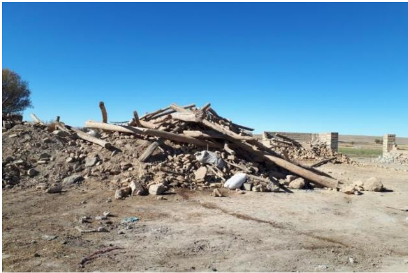
شکل ۲-۷۸: تخریب کامل محل نگهداری دام در روستای اسب فروشان
