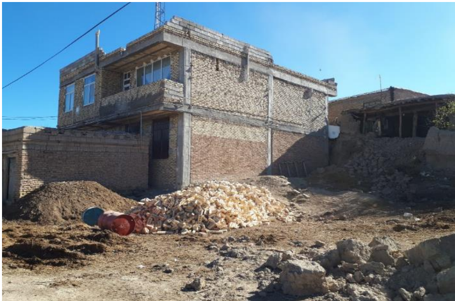
شکل ۲-۷۰ عملکرد مطلوب سازه اسکلت بتنی در کنار تخریب سازه بنایی خشتی و گلی در روستای دونیق
