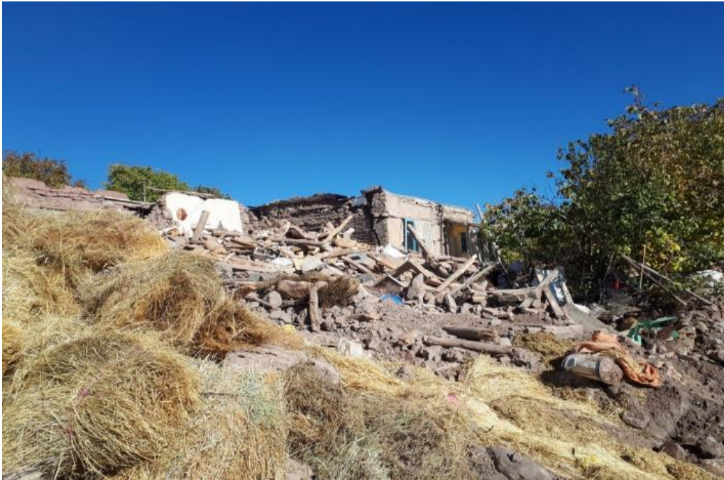
شکل ۲-۲۸ تخریب کامل ۳۰ سازه بنایی ضعیف در ورنکش
