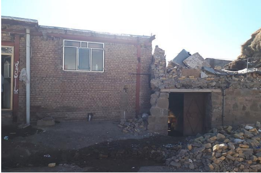
شکل ۲-۴۹ مقایسه رفتار لرزه‌ای سازه دارای اسکلت و سازه بتایی ضعیف در ورنکش
