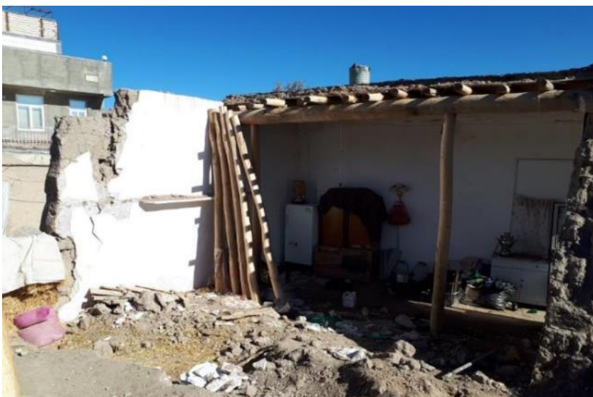
شکل ۷۳-۲ عملکرد ضعیف سازه بتایی بدون کلاف در برابر زلزله و تخریب آن
