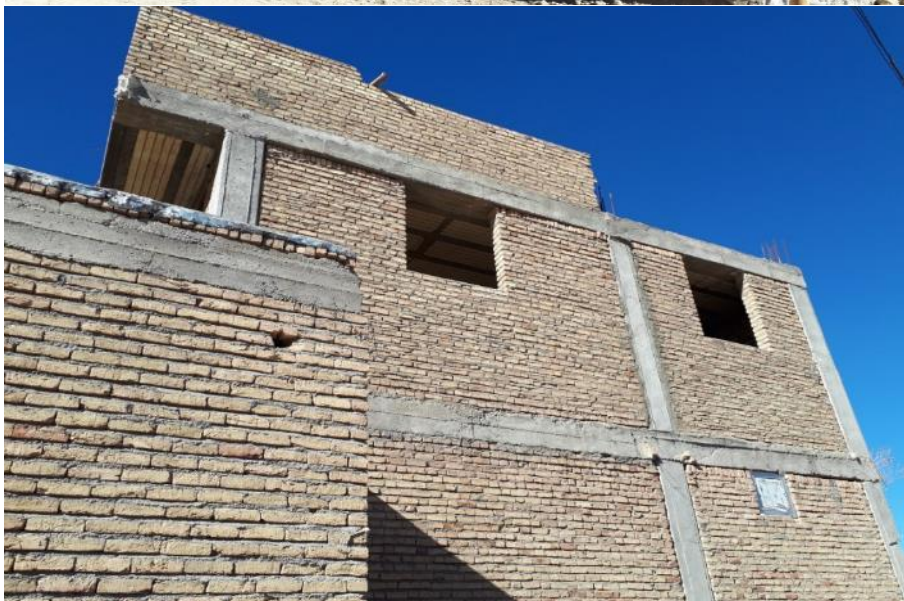
شکل ۲-۷۷ عملکرد مطلوب لرزه‌ای ساختمان‌های دارای اسکلت (اسکلت بتنی) در هروان
