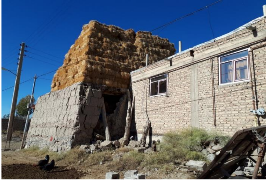
شکل ۲-۷۶ عملکرد مطلوب لرزه‌ای سازه‌های بنایی کلاف‌دار در هروان
