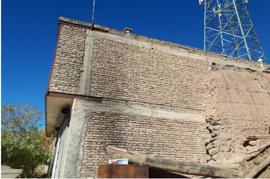
شکل ۴۰-۲ عملکرد مناسب لرزه‌ای سازه بتایی کلافدار در منطقه ورنکش
