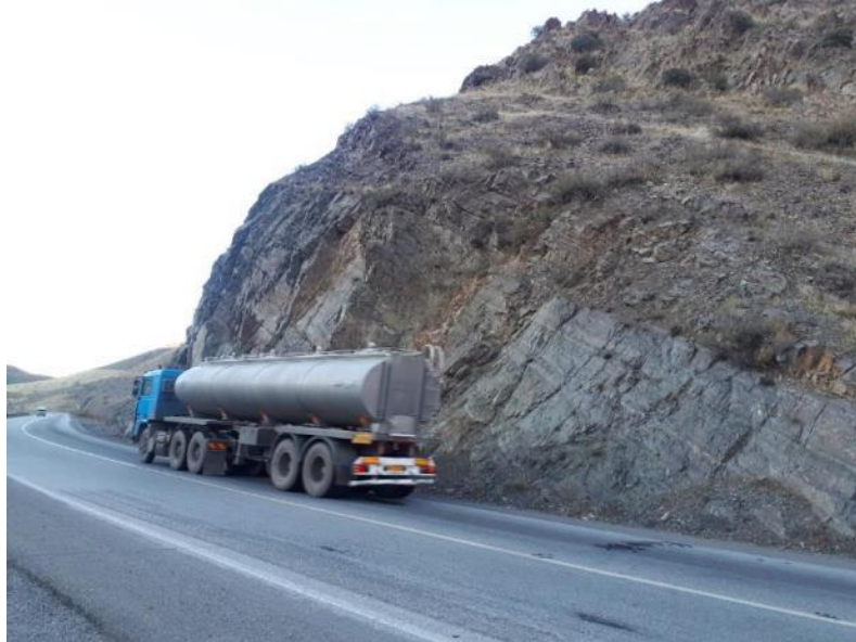
شکل ۳-۹ محور میانه - بستان آباد بعد از عملیات پاکسازی از واریزه‌های سنگی
