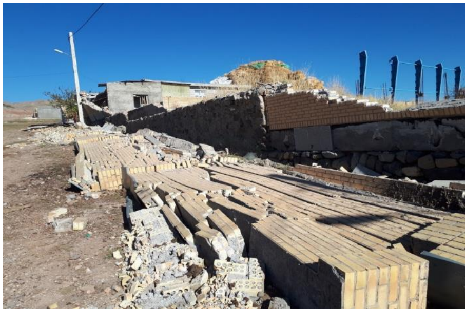
شکل ۲-۲۷ واژگونی چندین دیوار در روستای ورنکش (ضربه زدن به تاسیسات مجاور دیوار)
