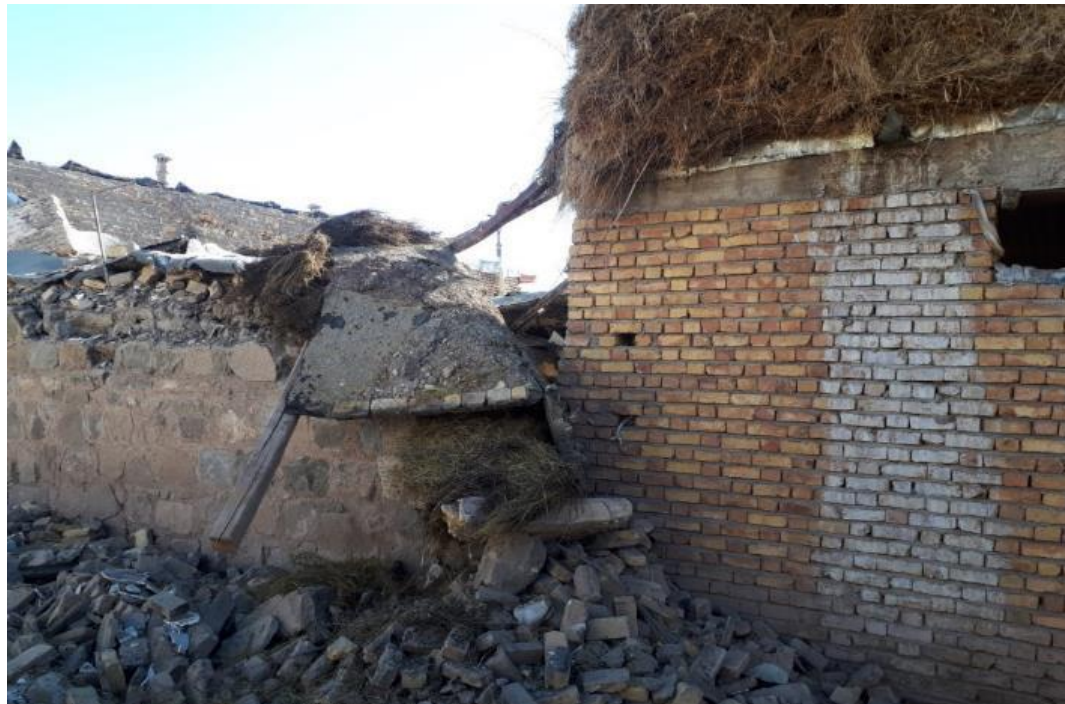
شکل ۲-۴۳ مقایسه رفتار لرزه‌ای سازه بنایی کلافدار و بدون کلاف در ورنکش (تخریب کامل سازه بدون کلاف)
