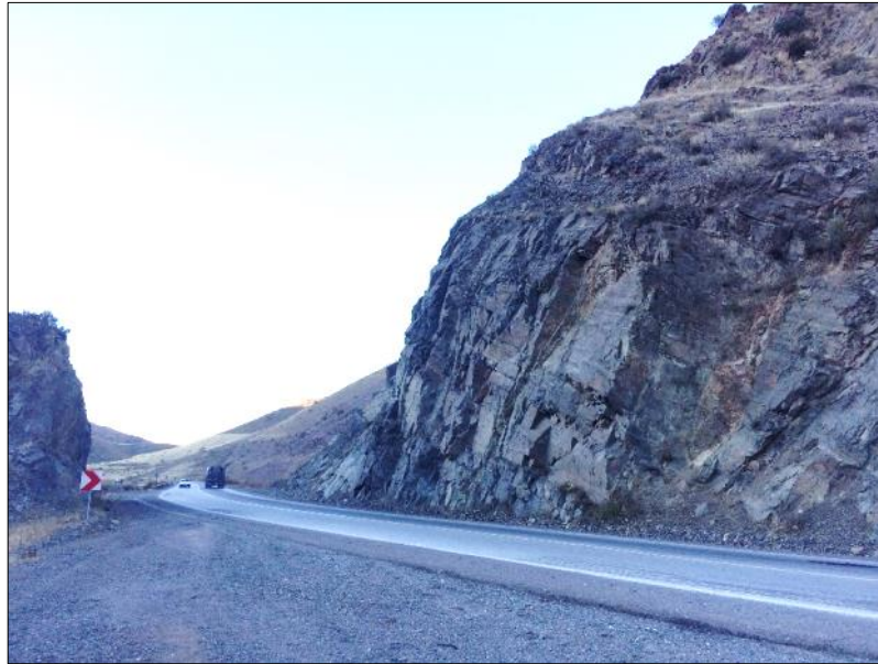
شکل ۱-۲۰: یکی از نقاط ریزش کوه در جاده میانه- ترکمانچای که توسط نیروهای راهداری میانه پاکسازی شده است. موقعیت:
