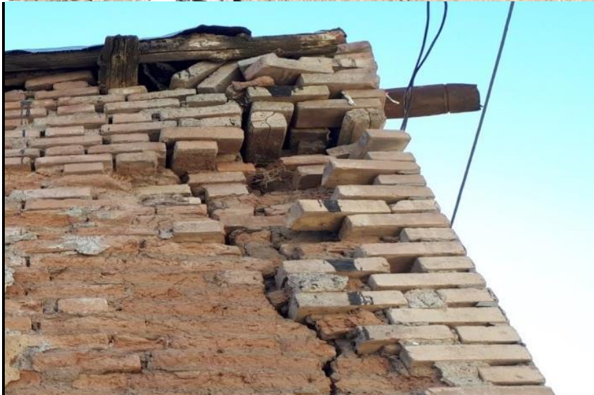
شکل ۲-۷ بروز گسیختگی بین دیوارهای متعامد
