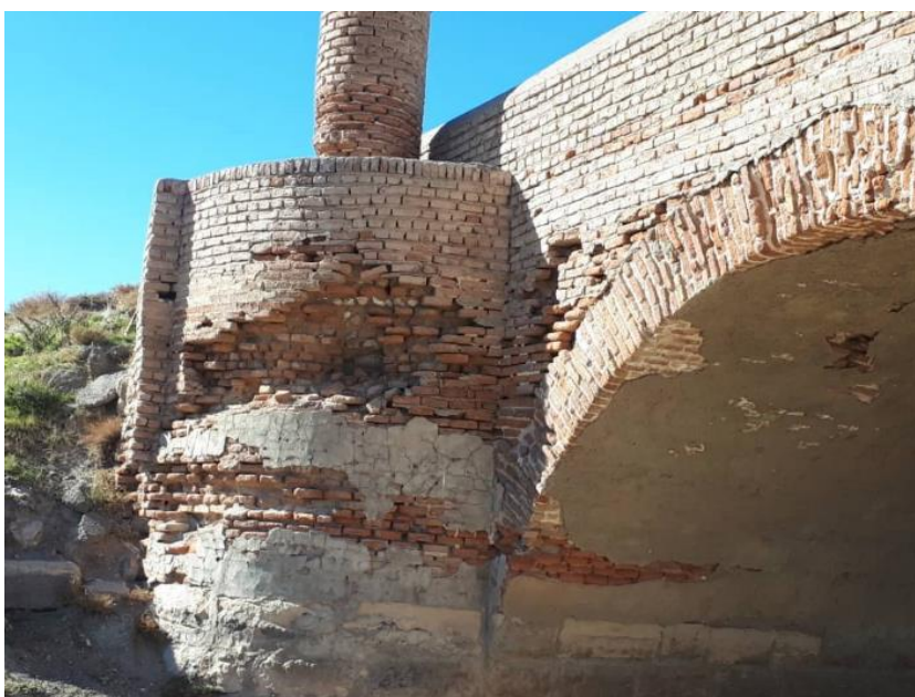
شکل ۲-۱ پل باستانی واقع در شهرستان سراب که در اثر زلزله آسیب دیده است
