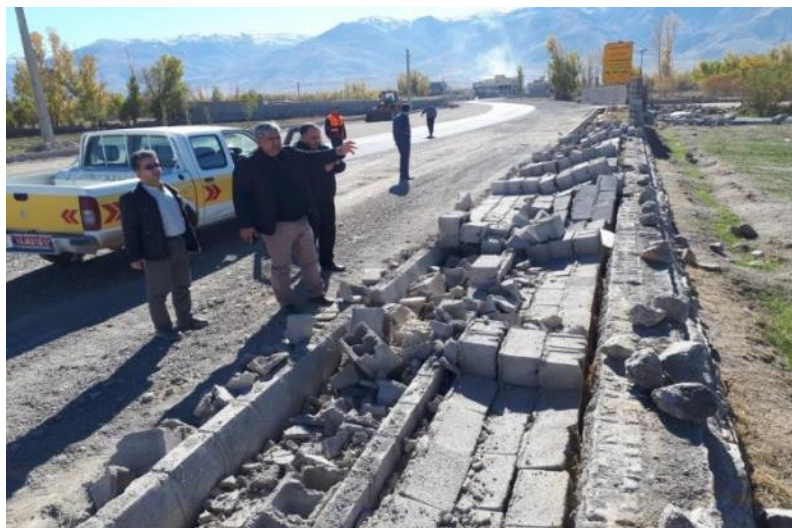
شکل ۲-۷۹: تخریب کامل دیوارهای محوطه برخی اماکن
