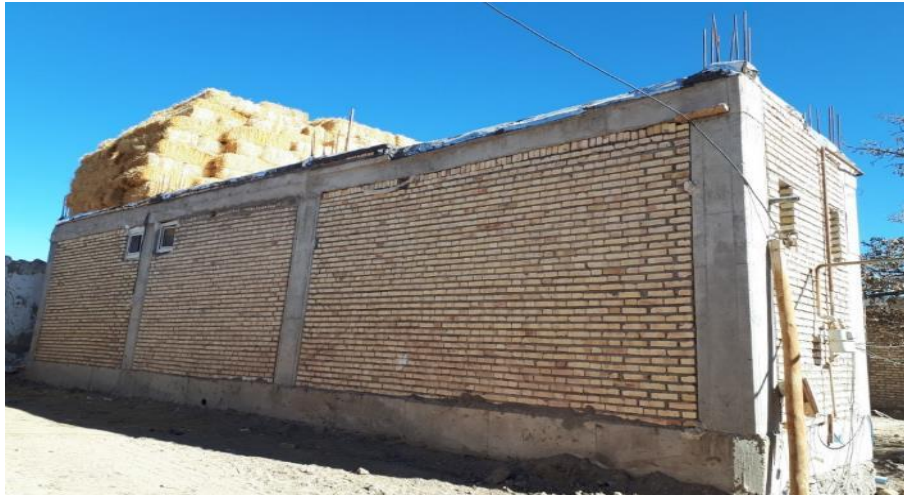
شکل ۲-۷۶ عملکرد مطلوب لرزه‌ای سازه‌های بنایی کلاف‌دار در هروان
