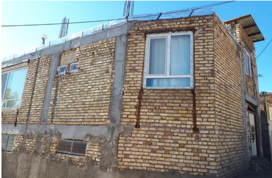
شکل ۲-۵۰ حفظ پنجره و دیوارها با تکنیک‌های ساده مهار (هرچند ضوابط اجرایی به طور کامل رعایت نشده است)
