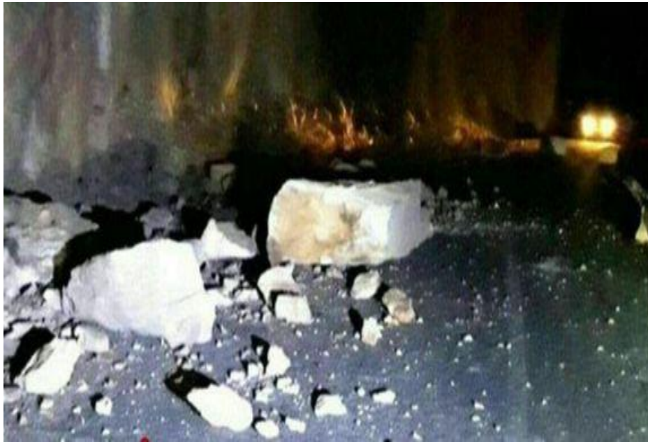
شکل ۳-۸ ریزش سنگ و انسداد مسیر در محور میانه - بستان آباد
