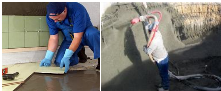
شکل 1-3: روش اجرا و نصب ملات
