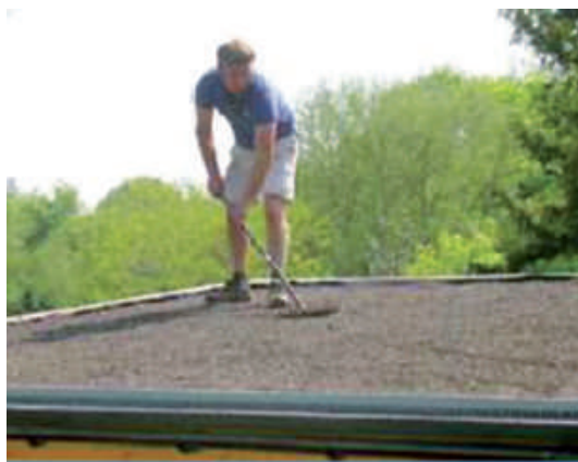
شکل ۱-۷. استفاده از پرکننده لیکا در بام سبز
