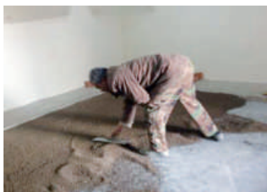
شکل ۵-۱۶. عایق‌کاری به روش دستی در کف صلب
