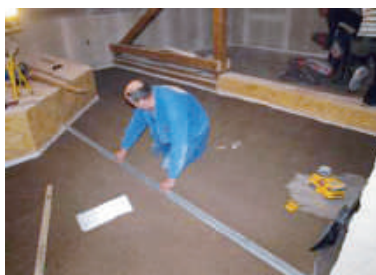
شکل ۵-۱۶. عایق‌کاری به روش دستی در کف صلب
