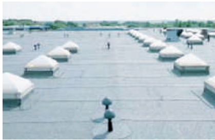
شکل ۵-۱۳. پوشش بام با سبک‌دانه رس منبسط
