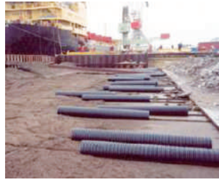
شکل ۱-۱۱. استفاده از پرکننده لیکا در بنادر شکل ۱-۱۲. استفاده از پرکننده لیکا در راه آهن
