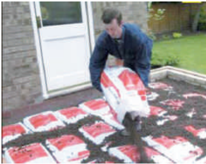
شکل ۵-۲. تسطیح کف با دانه‌های لیکا
