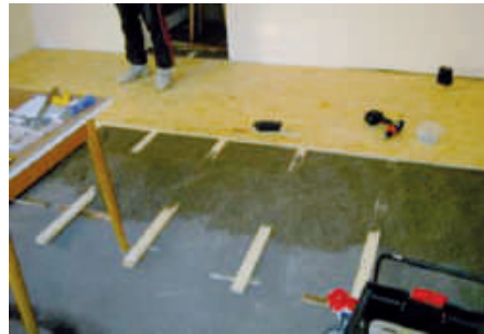
شکل ۵-۹. کاشی‌کاری و عایق سبک‌دانه‌ای همزمان
