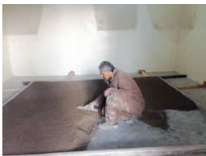
شکل ۵-۶. تسطیح سبک‌دانه در کف
