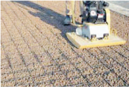
شکل ۵-۱۱. عایق کاری بام شیب‌دار با سبک‌دانه شکل ۵-۱۲. استفاده از شبکه فلزی بر روی سبک‌دانه در بام
