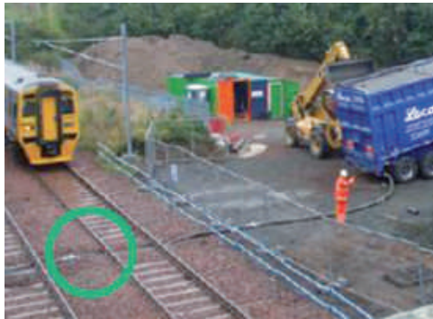
شکل ۱-۱۱. استفاده از پرکننده لیکا در بنادر شکل ۱-۱۲. استفاده از پرکننده لیکا در راه آهن
