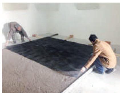
شکل ۵-۷. استفاده از یک لایه مش پلاستیکی
