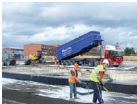
شکل ۱-۹. استفاده از پرکننده لیکا در راه‌سازی
