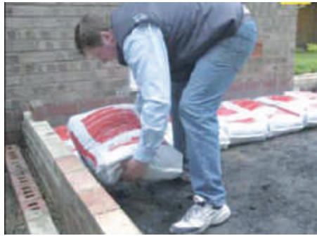
شکل ۵-۱. پر کردن سطح با کیسه‌های لیکا
