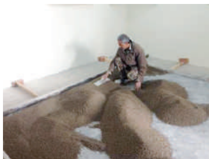
شکل ۵-۵. پخش کردن سبک‌دانه در کف
