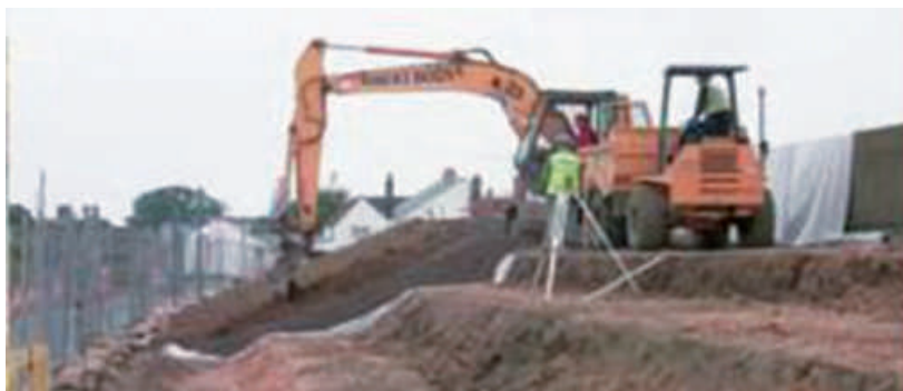
شکل ۱-۶. استفاده از پرکننده لیکا در زمین شیب‌دار
