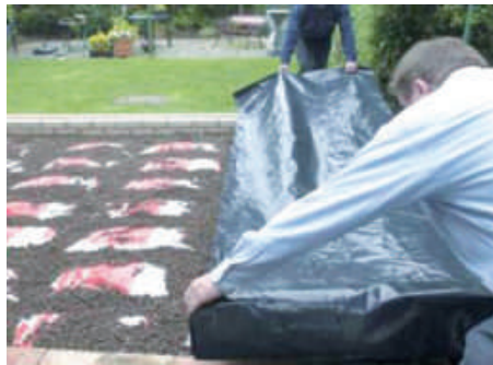
شکل ۵-۳. پوشش با عایق رطوبتی شکل
