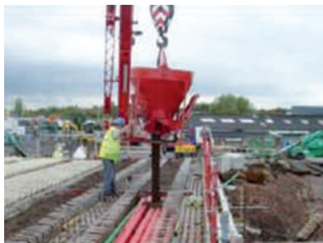
شکل ۱-۱۰. استفاده از پرکننده لیکا در پی‌سازی ساختمان
