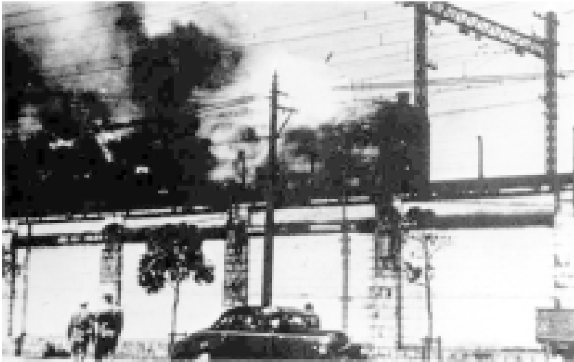
۴- آتش گرفتن قطار در ایستگاه ساکورای یوکوهاما (۲۴ آوریل ۱۹۵۱)، بعلت جرقه‌ی کابل بالاسریِ خط برقی در مین عملیات تعمیرنگهداری
