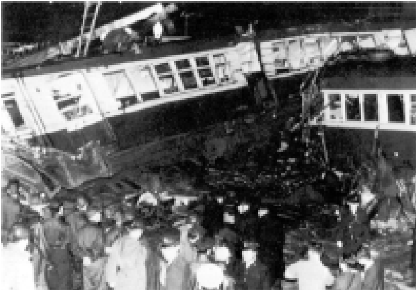
۷- بر فورده چند قطار در فط اصلی توکایدو در نزدیکی ایستگاه تسورو می (۹ نوامبر ۱۹۶۳). علت سانحه: برون رفت یک قطار باری و مسدود کردن چندین فط مجاور.
