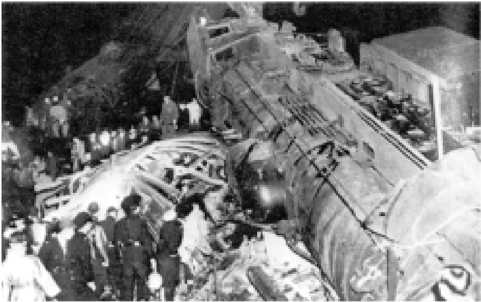
۵- برافورد دو قطار در ایستگاه روکن، خط سان گو (۱۵ اکتبر ۱۹۵۶). علت این برافورد در بد فهمیدن علامت (از سوی راننده) و کمی قدرت ترمز بود.
