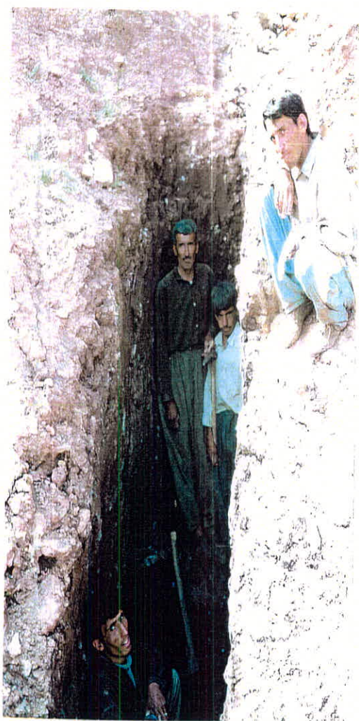
عکس شماره ۱۳ حفر ترانشه بر روی لایه نمک با بیش از عمق ۲ متر. همانطور که در عکس مشخص است پوشیدگی لایه معدنی توسط رسوبات رس و مارن ترانشه زنی را با مشکل مواجه کرده است. (منطقه تختان دید به سمت شمال)
