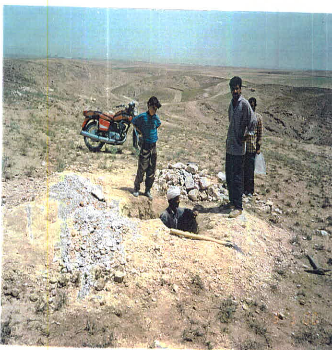
عکس شماره (۸-۳) - وضعیت ظاهری چاهک Tp-2 و تشکیل رسوبات خاکی حاصل از فرسایش و
