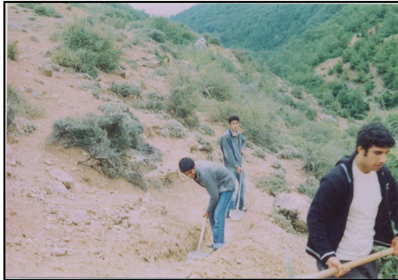
تصویر ۲-۳۳: نمایی از ترانشه در حال احداث بر روی رخنمون‌های لاتریتی در جنوب روستای پائین‌ده (نگاه به جنوب)
