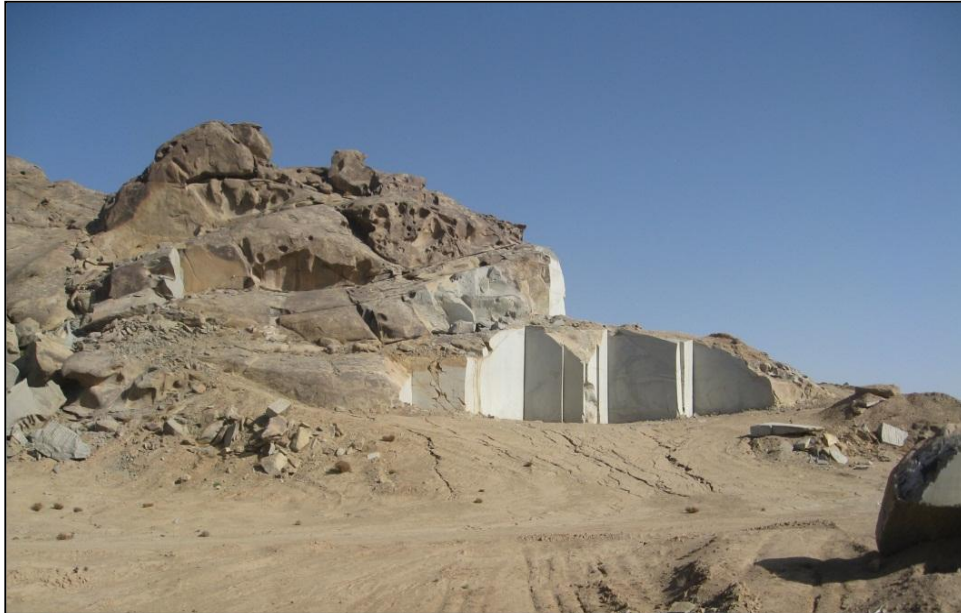
شکل ۲-۳۳ - نمایی از سینه کارهای احداث شده
