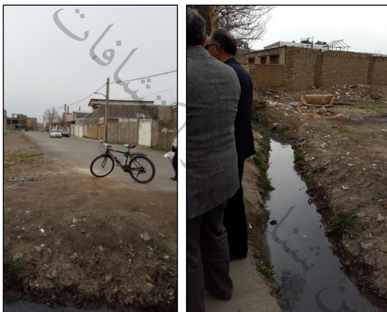
شکل ۳-۲- احداث جاده آسفالتی در مسیر قدیمی رودخانه روستای نجم آباد
