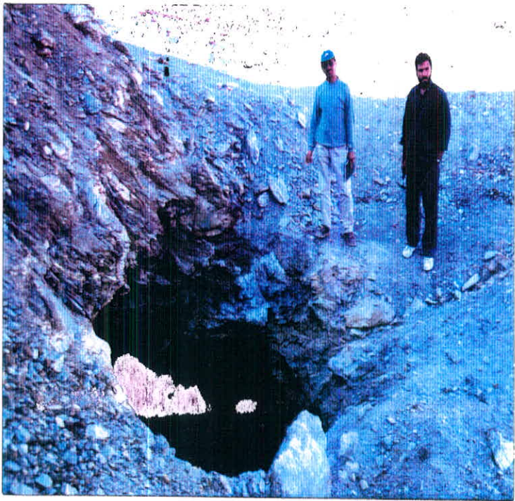
شکل ۳-۵۲: تونل دنباله روی اصلی رگه در ایستگاه B۲۳
