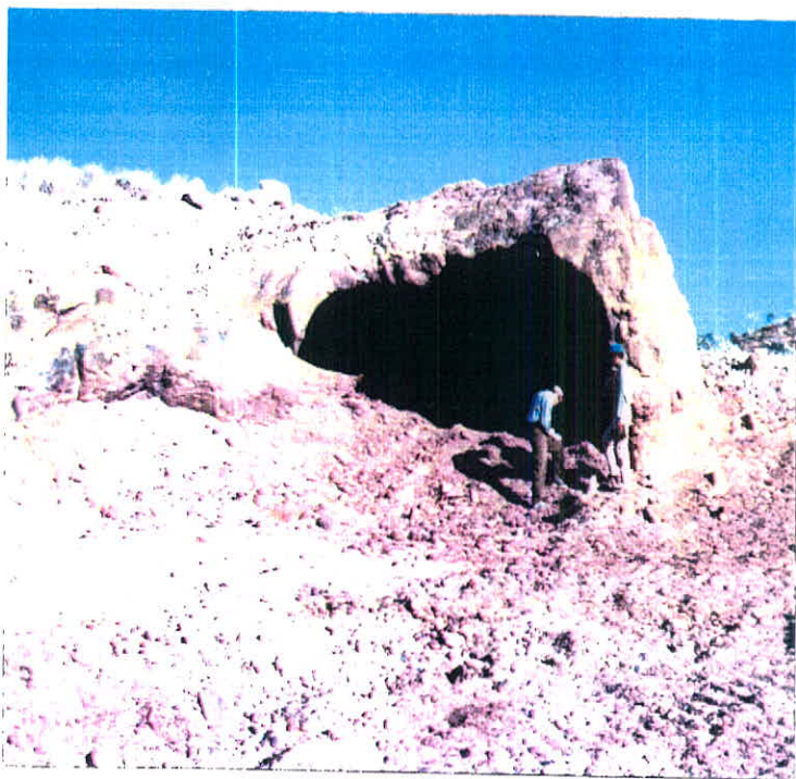
شکل ۳-۵۳: یکی دیگر از تونل های حفاری شده در ایستگاه B۲۳
