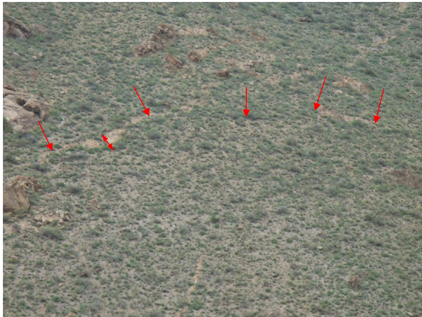
شکل ۷: ترک کششی ایجاد شده در تاج لغزش ایجاد شده در دامنه باختری در منطقه کارگاه. (دید به سوی باختر)
