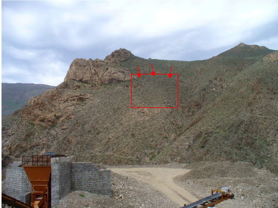
شکل ۶: لغزش در حال شکل‌گیری در دامنه باختری روبروی کارگاه. محدوده مشخص شده در شکل ۷ نشان داده شده است. (دید به سوی باختر)
