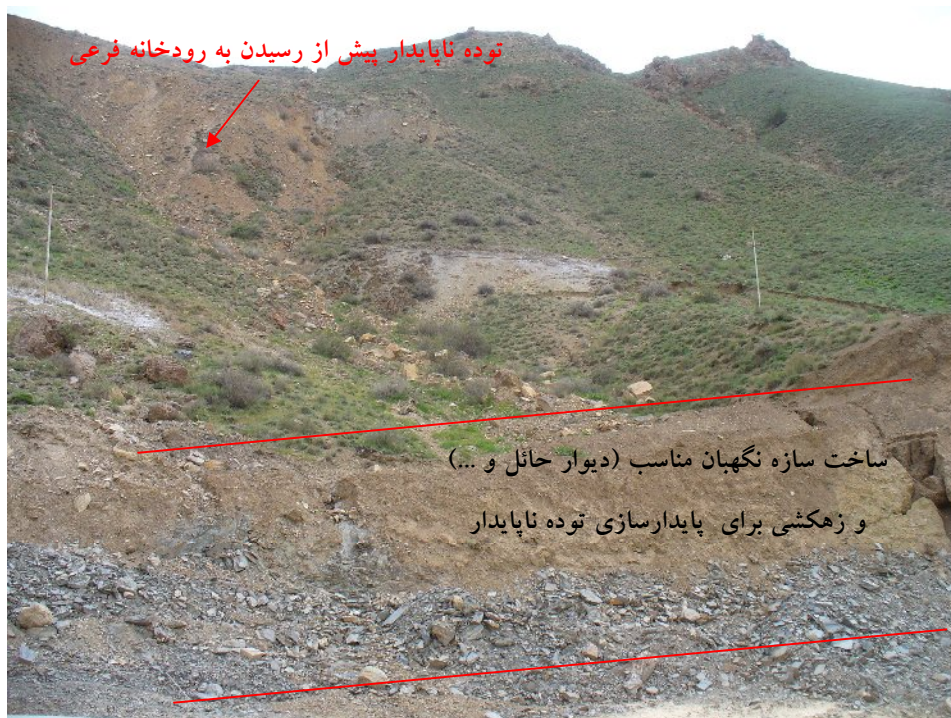
شکل ۵: ساخت سازه نگهدار مناسب و زهکشی برای پایدارسازی دامنه و توده ناپایدار. (دید به سوی خاور)
