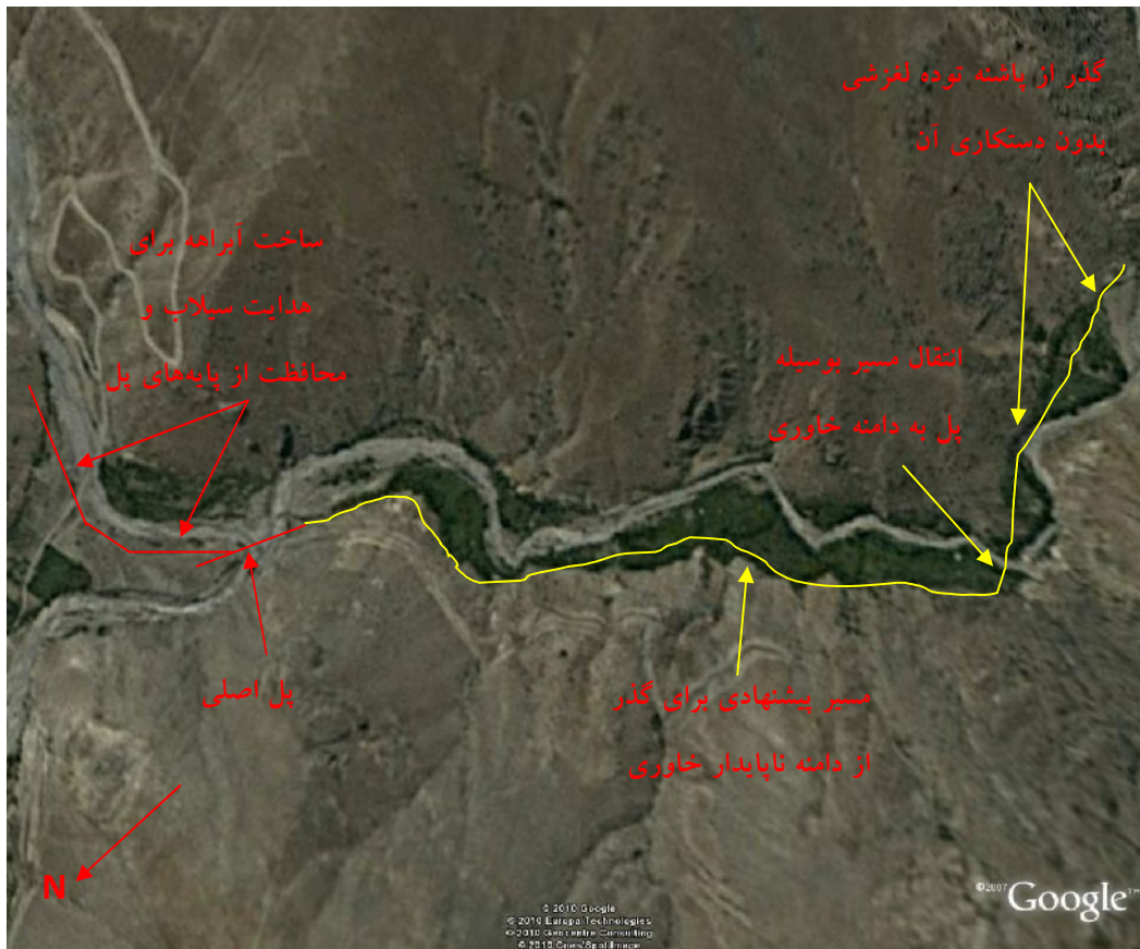
شکل ۱۲: انتقال مسیر پروژه بوسیله پل به دامنه باختری، برای دوری جستن از ناپایداری‌های دامنه خاوری. سپس مسیر بوسیله پل به دامنه خاوری منتقل شده و از پاشنه توده لغزشی در حال شکل‌گیری (کیلومتر ۲۴.۵ تا ۲۵)، بدون هرگونه دستکاری آن و با خاکریزی در پاشنه لغزش (کناره خاوری رودخانه)، با پارگذاری بر روی توده از آن عبور کند.
