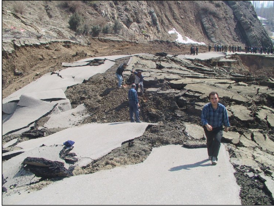
شکل ۴: تخریب راه بوسیله زمین لغزش جاده اوشان - قشم ۱۳۸۳. (دید به سوی جنوب خاوری)
