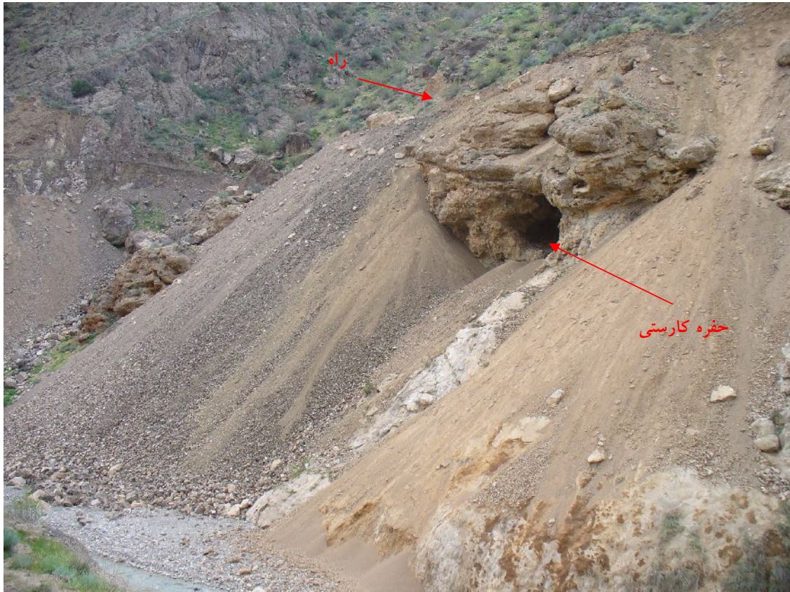
شکل ۱۵: وجود حفرة های آهکی و کارست در زیر بستر راه می‌تواند سبب تخریب راه در آینده گردد. (دید به سوی جنوب باختر)
