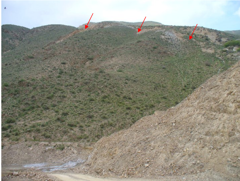
شکل ۴: سطح لغزش ایجاد شده در دامنه باختری (دامنه رو به خاور). ایجاد شبکه زهکشی برای خارج کردن آب از دامنه‌ها ضروری است. (دید به سوی باختر)
