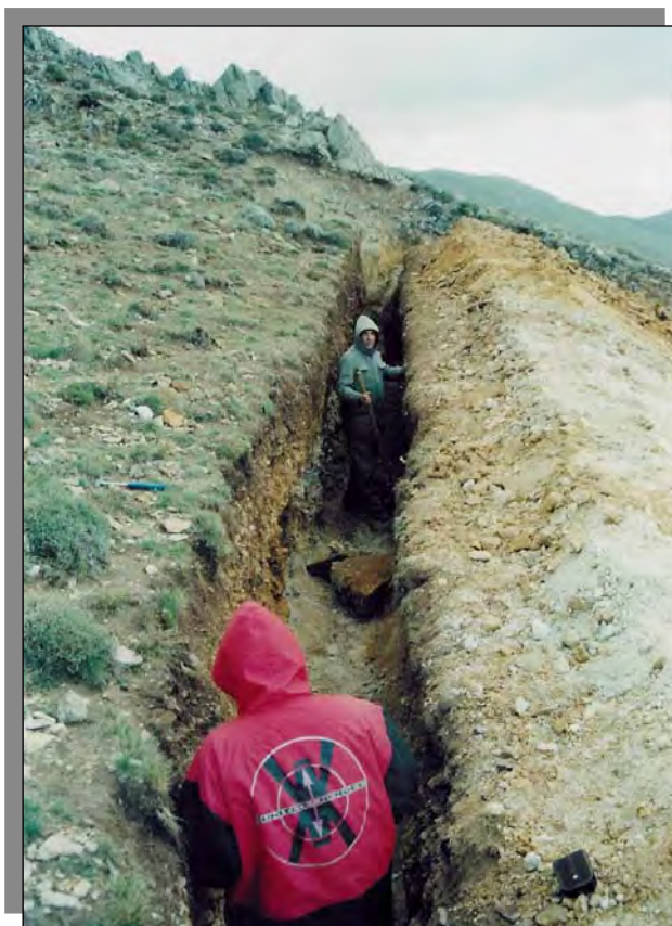
تصویر شماره ۳۱-۳- ترانشه شماره ۴ (نگاه به سمت شمال باختری)
