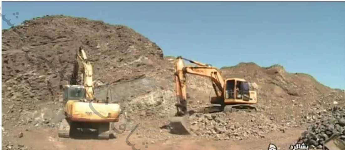
شکل ۳-۱۱- نمایی از معدن منگنز گهرکوه اسلام آباد بشاگرد
