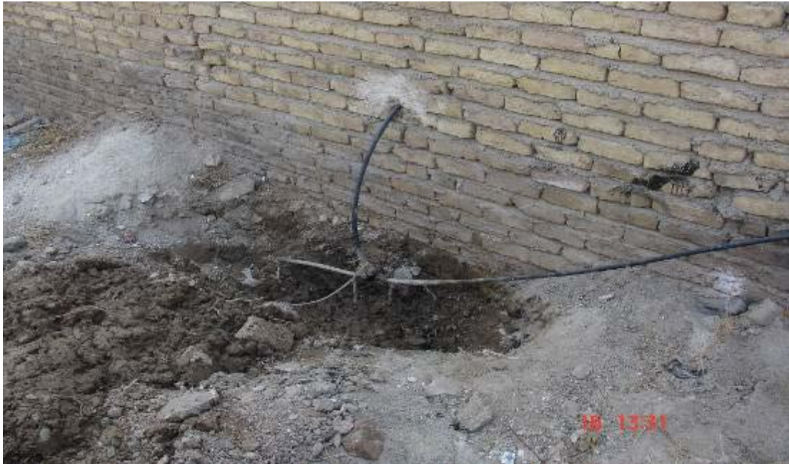
شکل ۸- محل لوله و نشت آب از لوله به گفته اهالی مدت‌ها این لوله نشت داشته است.
