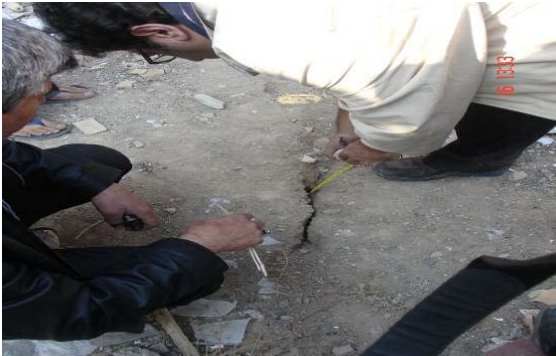
شکل ۳- ترکهای ظاهر شده در زمین پشتی خانه های آسیب دیده
