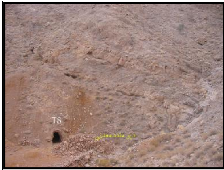
شکل 46- نمای نزدیک از تونل T 8 - دید به سمت جنوب شرق.
