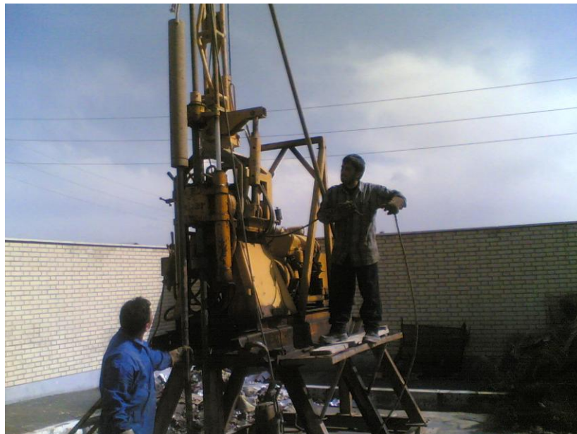
شکل ۴- انجام آزمایش نفوذ استاندارد، SPT
