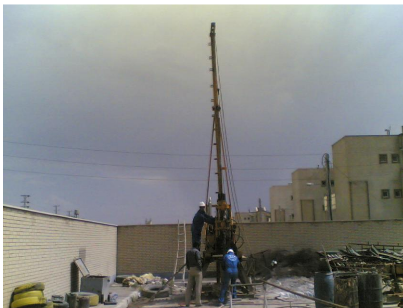
شکل ۲- دستگاه حفاری SKB500 در حال کار در کارگاه بردآباد
