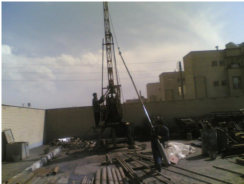
شکل ۱- دستگاه حفاری Acker در حال کار در کارگاه بردآباد
