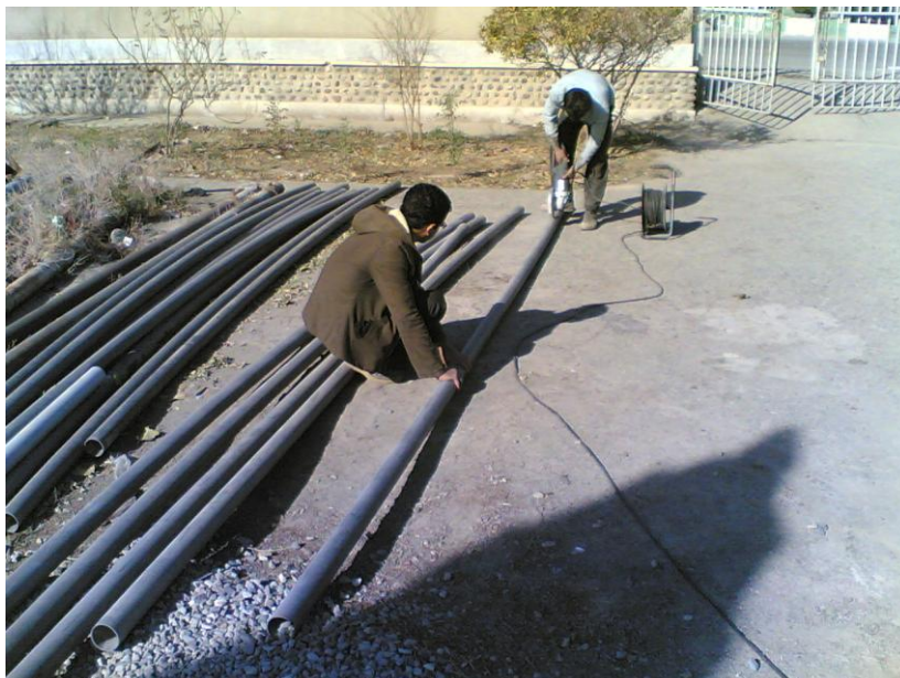
شکل ۹- شیاردار نمودن لوله‌های PVC
