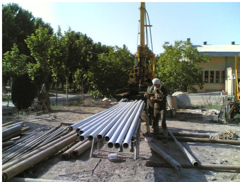
شکل ۸- لوله‌های PVC آماده شده برای داخل گمانه
