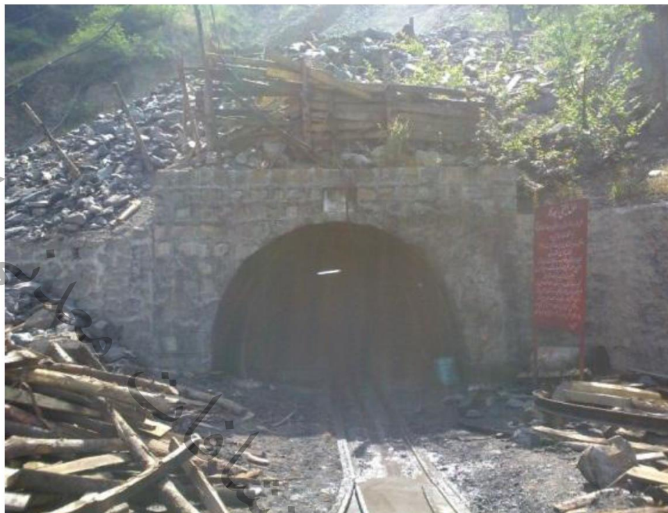
شکل ۳-۱۷- ورودی یکی از تونل های معدن رضی
