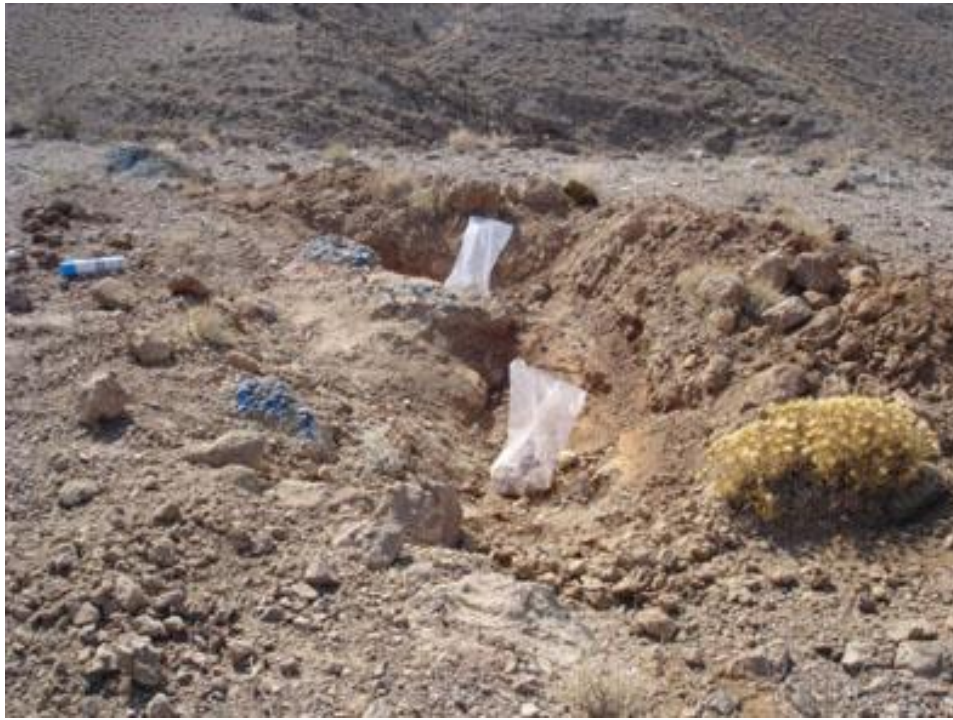
عکس شماره 3-31: نمایی از ترانشه TR2. (دید بسمت جنوب غرب)
