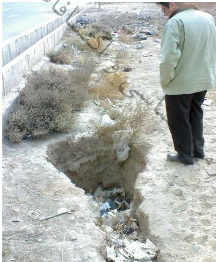
شکل ۹- چاله ای که احتمال می رود که از بقایای میله چاه یک قنات قدیمی باشد
