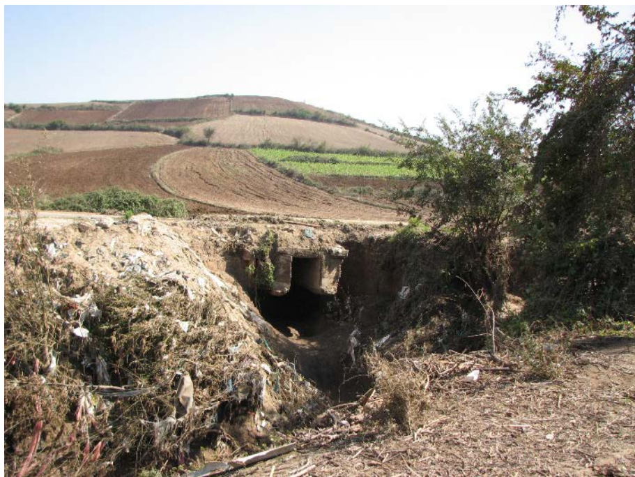
شکل ۱۷- فرسایش زمین زیر کانال آب بر اثر سیل در محل ورود از سمت غرب خشک دره
