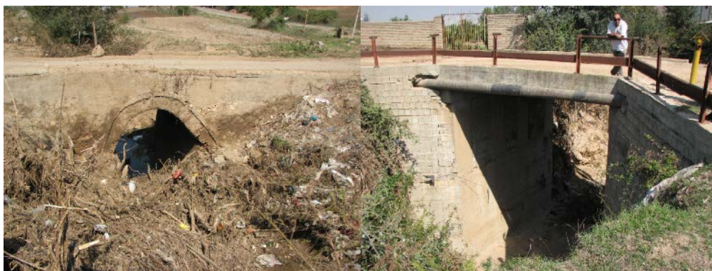
الف- عرض ۴ متر و ارتفاع ۷ متر ب- عرض ۲/۷ متر و ارتفاع معادل ۳/۷ متر
