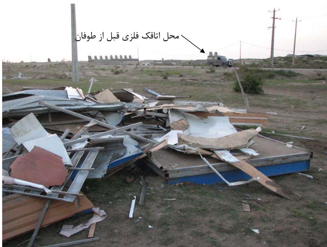
شکل ۸- تخریب اتاقک فلزی مرکز تحقیقات زمین شناسی دریای خزر
