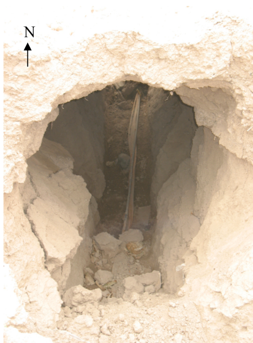
تصویر شماره ۱۳- نمایان شدن مسیر انتقال کابل فیبر نوری مخابرات (A۱۵)
