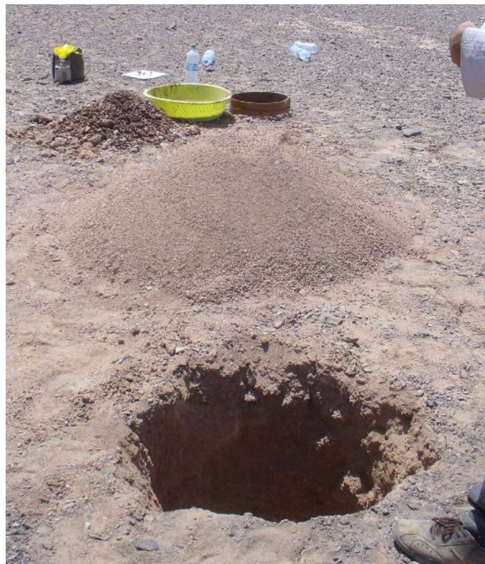
تصویر ۲-۸۲: ترانشه و چاهک حفر شده در محدوده عرب آباد - دهنو
