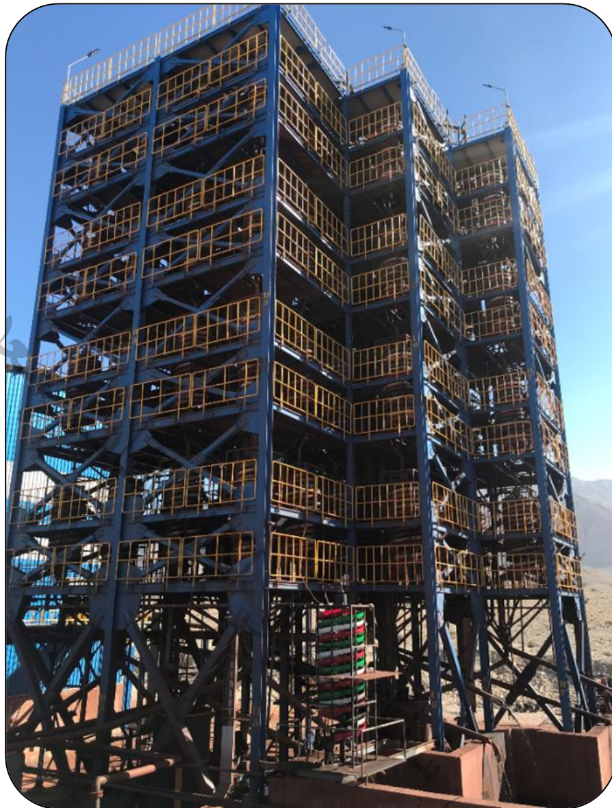
شکل (۳-۴): تصویر از چهار طبقه اسپیرال جهت پرعیارسازی ثقلی محصول معدن تنگه زاغ
