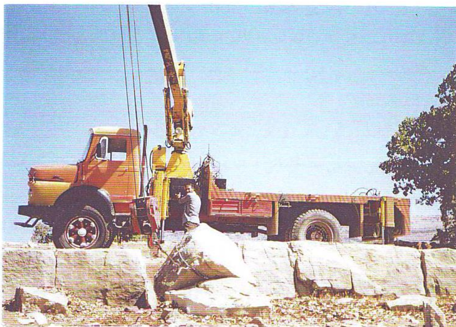
عکس شماره ۸۴- کندن بلوک سنگی از توده سنگ بوسیله جرثقیل
