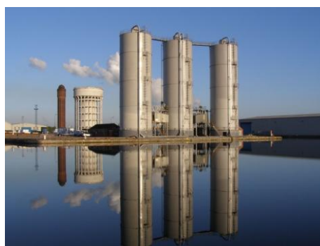
شکل ۲-۱۱-۷ انبار کردن سیمان در سیلوها با ابعاد و اندازه‌های مختلف بر حسب نوع و مشخصات استفاده
