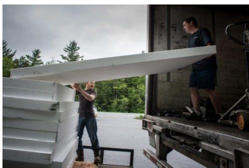
شکل ۲-۴-۶- حمل دستی عایق حرارتی
