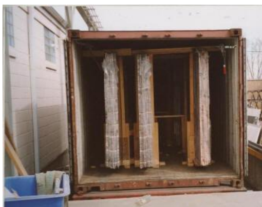
شکل ۲-۱۳-۸- کنترل و نگهداری پلاک‌ها در پشت کامیون با چوب چار تراش
