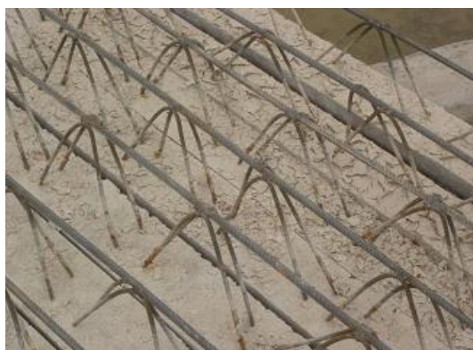
شکل ۲-۱۸-۲- رسوبات حوضچه عمل آوری و گرد و غبار نشسته بر روی تیرچه‌ها قبل از نصب تیرچه باید به طور کامل از سطح پاشنه بتنی زدوده شوند
