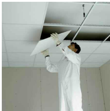
شکل ۲-۸-۱ نصب سقف پوش های گچی روی زیرسازه های از پیش اجرا شده
