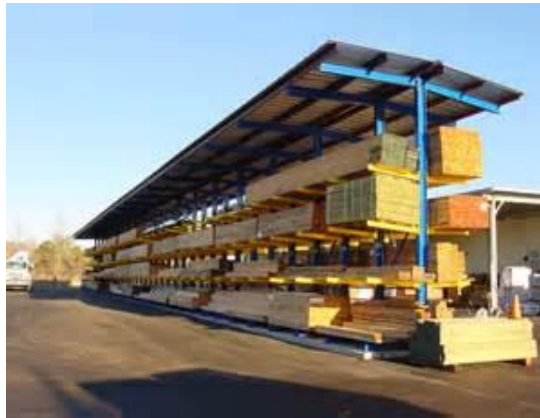
شکل ۲-۲۷-۷- هانگار باز بدون دیوار جانبی برای نگهداری چوب آلات خشک
