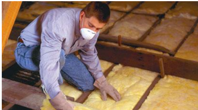
شکل ۲-۴-۸- استفاده از دستکش و ماسک هنگام کار با پشم‌های معدنی
