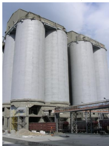
شکل ۲-۱۱-۳ نگهداری سیمان فله فقط در سیلو مجاز است
