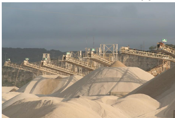
شکل ۲-۱۲-۸ انبارش مصالح سنگدانه‌ای در فضای روباز و استفاده از تسمه نقاله
