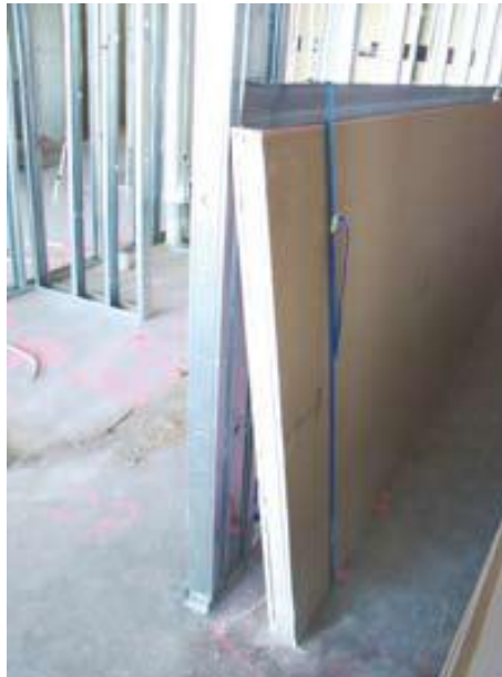
شکل ۲-۹-۵ نمونه‌ای از مهار کردن صفحات روکش دار گچی
