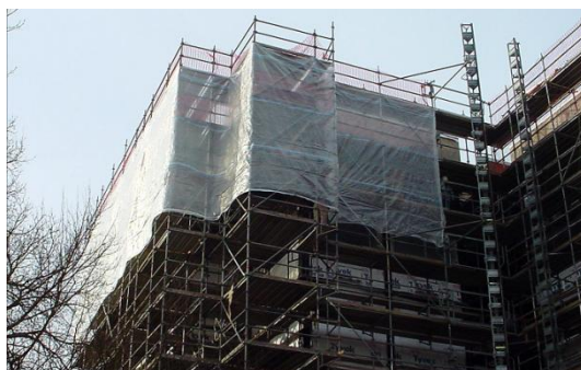
شکل ۲-۱۱-۱- حفاظت از کار بنایی در هوای سرد
