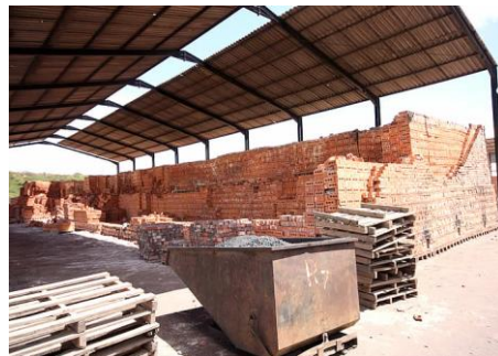
شکل ۲-۱-۱۲- ذخیره سازی آجرها در سایه یا زیر پوشش مناسب
