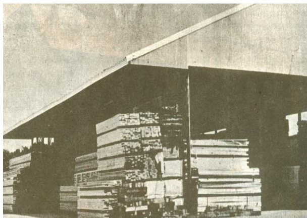
شکل ۲-۲۷-۹- هانگار باز برای انبار کردن چوب‌آلات خشک، دسته‌های پوشیده و باز
