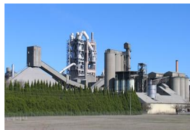
شکل ۱-۱۱-۲ سیمان از آسیاب کردن کلینر همراه با کمی سنگ گچ در کارخانه تولید سیمان حاصل می شود
