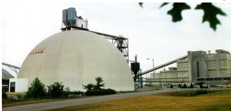
شکل ۲۰-۱۱-۲ انبار سیمان با حداقل تماس رطوبتی با بیرون، می‌سی‌سی‌پی، آمریکا
