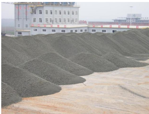
شکل ۲-۱۱-۵ انبار کردن سیمان در فضای باز، فقط در مواقع اجباری و ضرورت قابل پذیرش است
