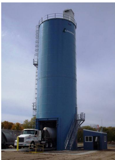
شکل ۲-۱۱-۳ نگهداری سیمان فله فقط در سیلو مجاز است
