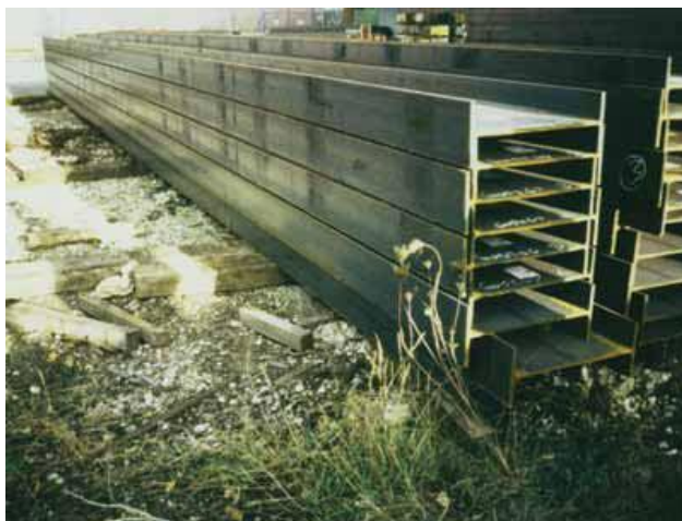
شکل ۲-۱۴-۲- نمونه‌ای از انبار غیرمسقف
