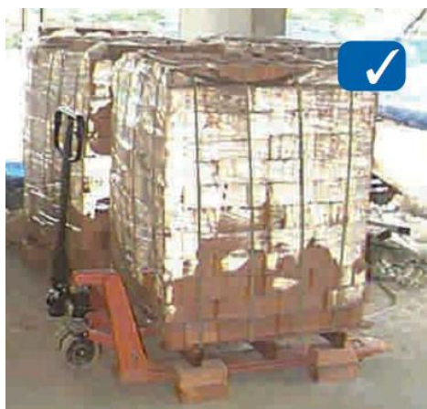
شکل ۲-۱-۱۷- جابجایی آجرها با جک پالت
