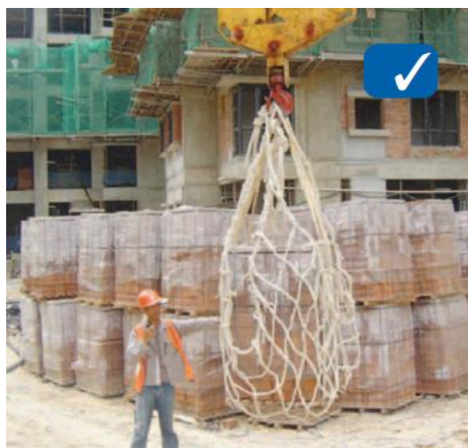
شکل ۲-۱-۱۸- برداشتن آجرها همراه با پالت
