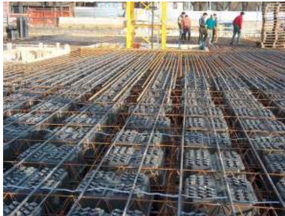
شکل ۱۴- نمای سقف بتنی حاوی مکعب‌های U-boot
